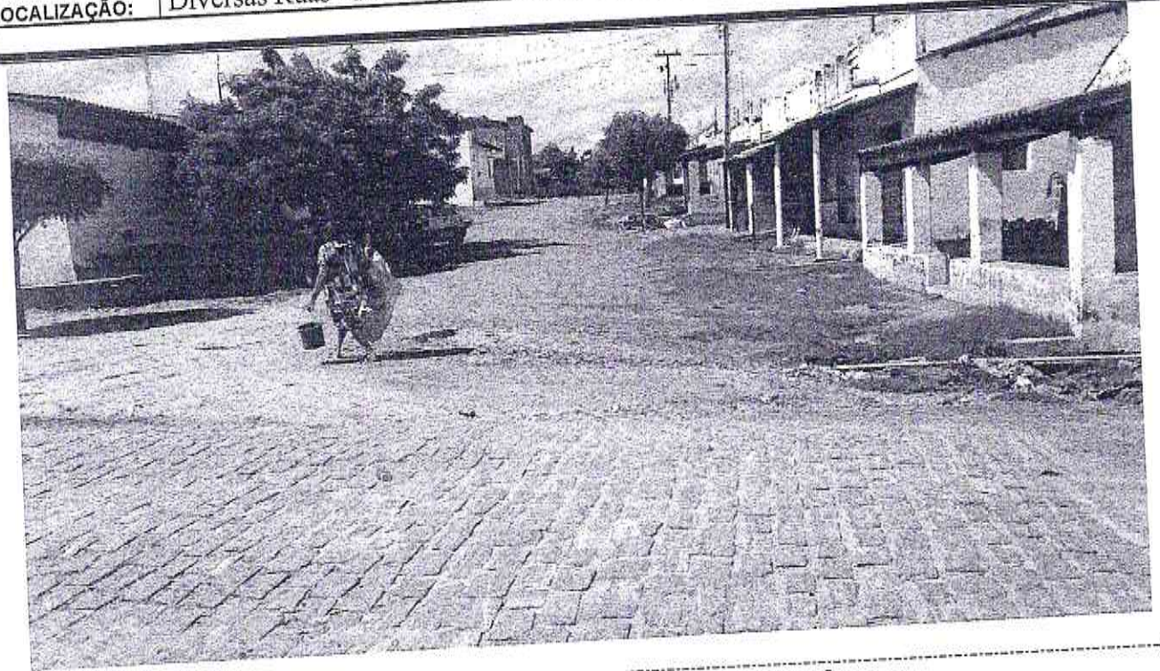
Início (Estaca E00) da Rua Moisés Rabelo UTM 543979.00/9428659.00
