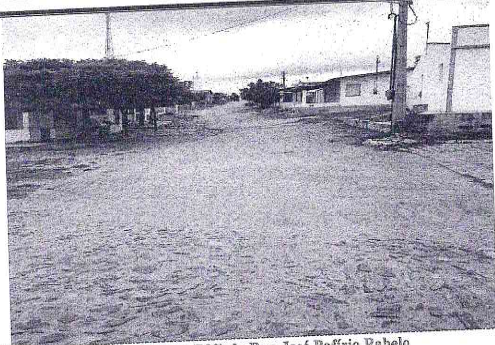
Início (Estaca E00) da Rua José Poffrio Rabelo UTM 544083.75/9428521.43
