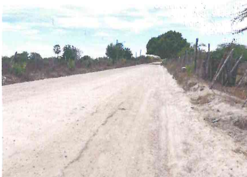
Trecho 01: (Estaca E43)
