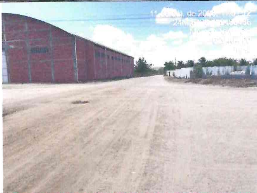
Trecho 01: Fim da Pavimentação (Estaca E61+11,70)
