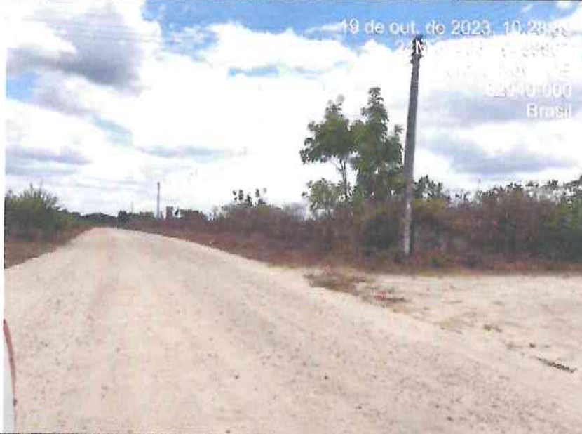
Trecho 02: (Estaca E57)
