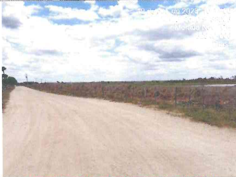
Trecho 02: Início da Pavimentação (Estaca 00)
