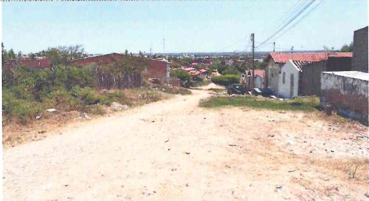
Final (E28 + 9,70m) da AV DOM ALUIZO A. DOS SANTOS (Bairro: NOSSA SENHORA DA CONCEIÇÃO) (Coordenada UTM 569546.98/9436706.44)
