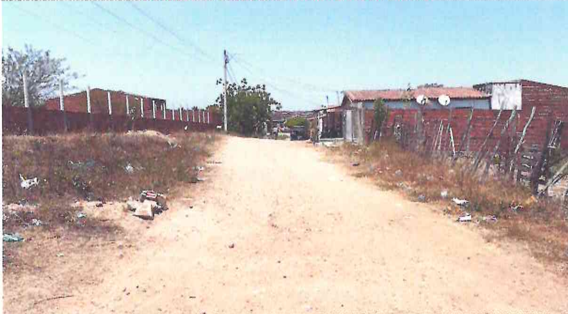
Final (E10 + 19,00m) da RUA OSCAR GIRÃO MOREIRA (Bairro: Nossa Senhora da Conceição) (Coordenada UTM 569477.00 /9436807.47)
