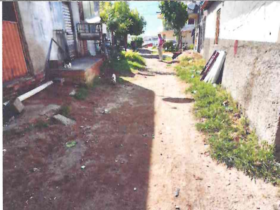
Início (Estaca E00) do Trecho da RUA QUINCAS GOMES (Bairro: SÃO JOSÉ) (Coordenada UTM 568579.17 / 9435850.66)
