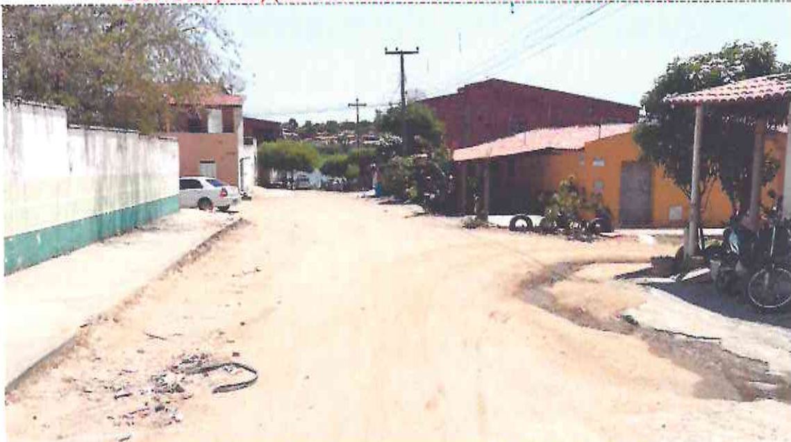
Final (E03 + 16,00m) da RUA JOSÉ DE SOUZA MARTINS (Bairro: NOSSA SENHORA DA CONCEIÇÃO) (Coordenada UTM 569489.23/9436141.87)
