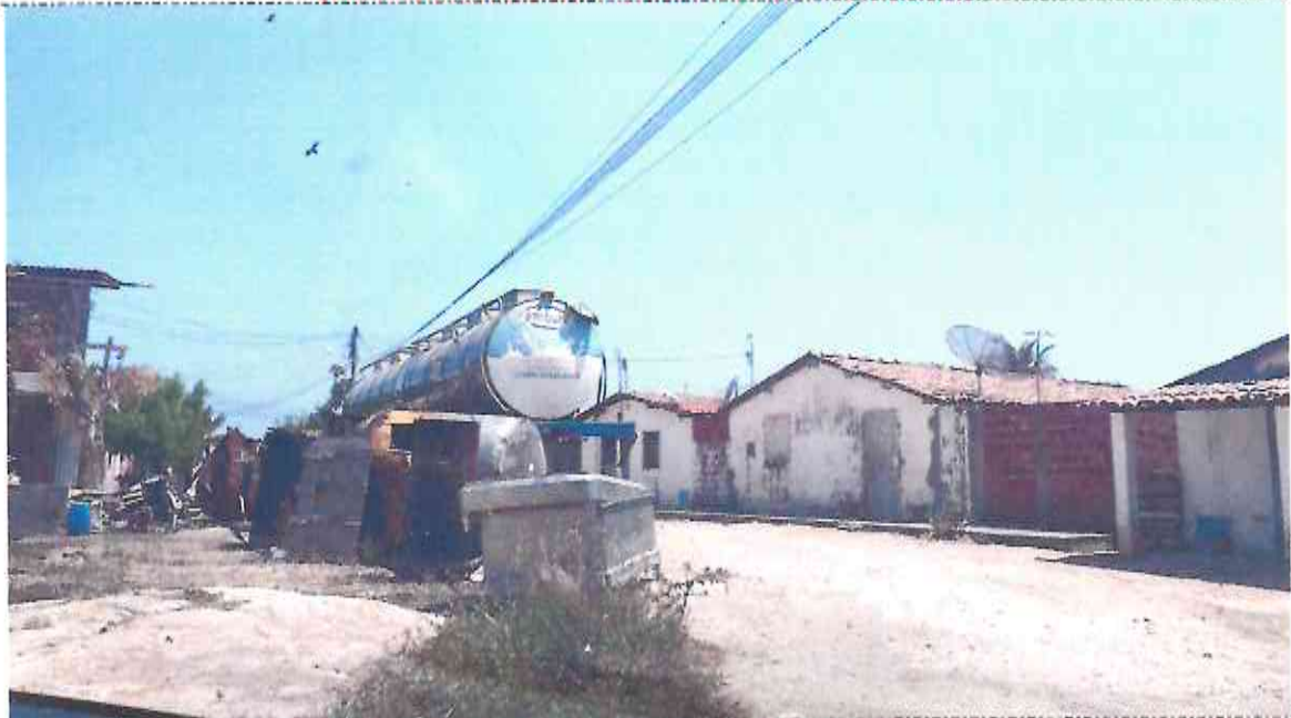
Final (E03 + 17,00 m) da TRAVESSA RDO VIANA (Bairro: ALTO TIRADENTES) (Coordenada UTM 571210.68 / 9435910.16)
