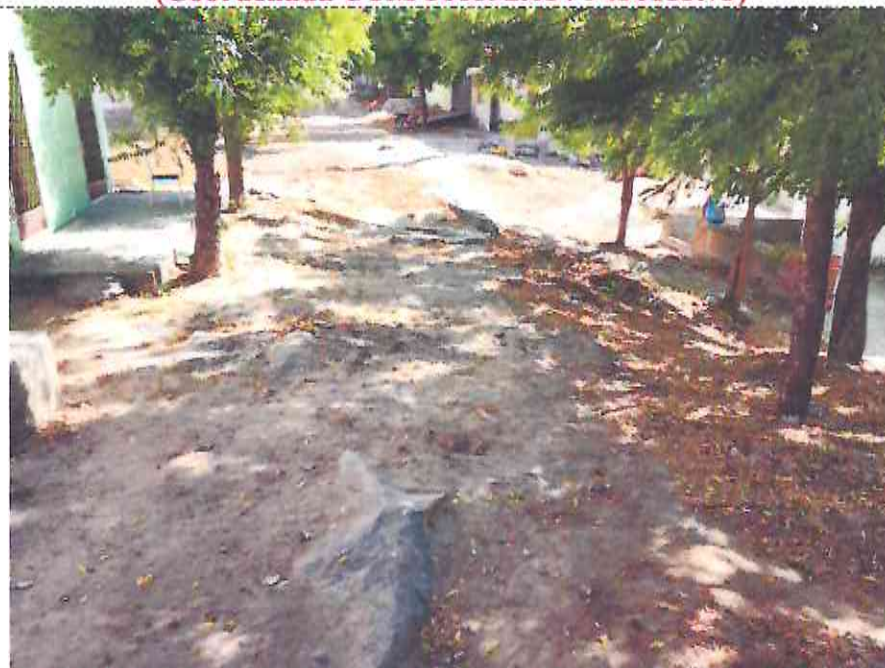
Final (Estaca E12 + 10,00m) da RUA JOAQUIM LIRA SARAIVA (trecho I) (Bairro: SÃO JOSÉ) (Coordenada UTM 568581.64 / 9435903.97)
