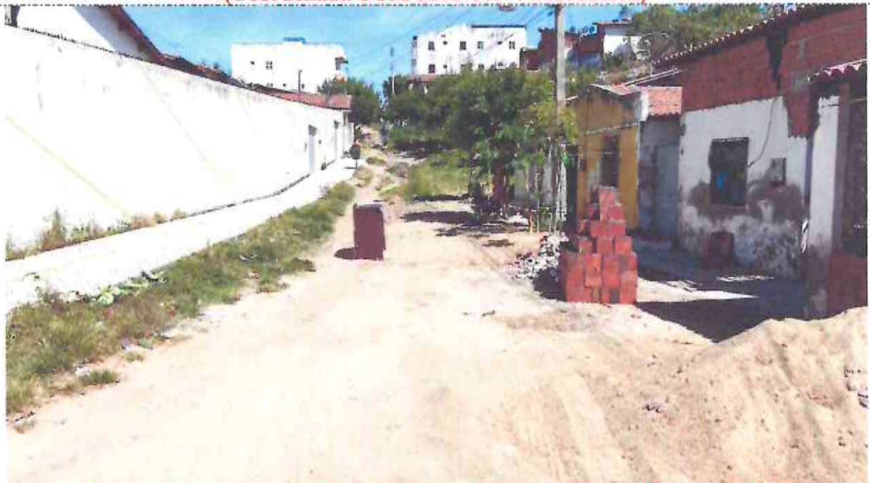
Final (Estaca E07 + 7,60m) do Trecho da RUA QUINCAS GOMES (Bairro: SÃO JOSÉ) (Coordenada UTM 568725.16 / 9435838.32)
