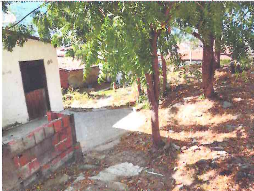
Final (E04 + 9,27m) da RUA JOAQUIM LIRA SARAIVA (trecho II) (Bairro: SÃO JOSÉ) (Coordenada UTM 568610.09 / 9435823.61)
