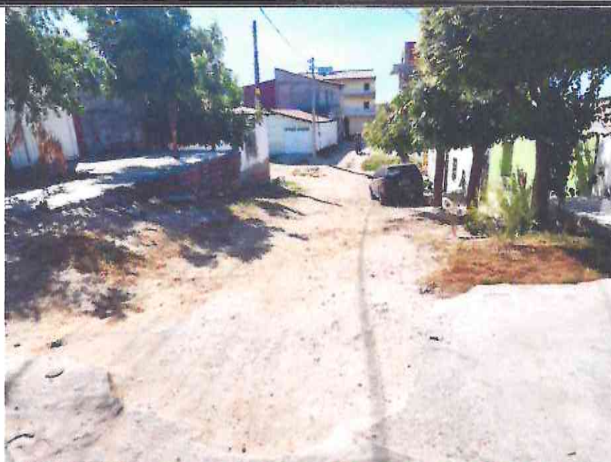
Início (Estaca E00) da RUA FRANCISCO GOMES DE ANDRADE (Bairro: SÃO JOSÉ) (Coordenada UTM 568518.01 / 9435840.44)
