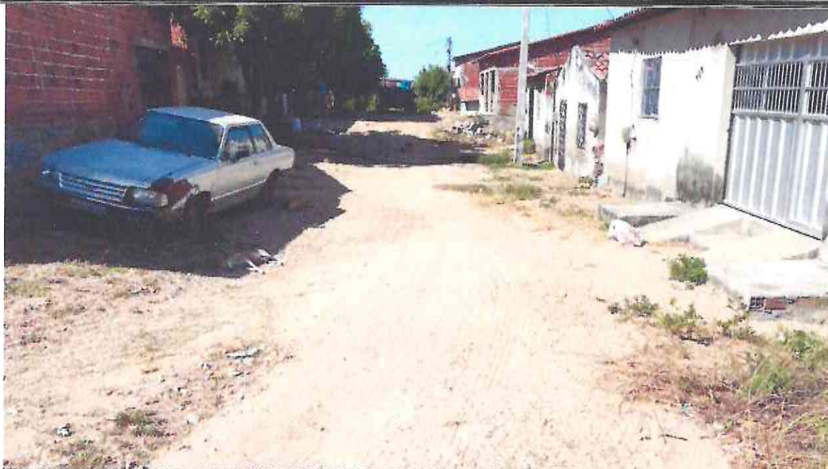
Início (Estaca E00) do Trecho da RUA SALUSTIANO DE CASTRO (Bairro: SÃO JOSÉ) (Coordenada UTM 568521.37 / 9436110.05)
