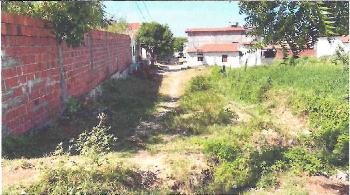
Início (Estaca E00) do Trecho da RUA JOSÉ LEANDRO DE CASTRO (Bairro: SÃO JOSÉ) (Coordenada UTM 568542.22 / 9435978.25)
