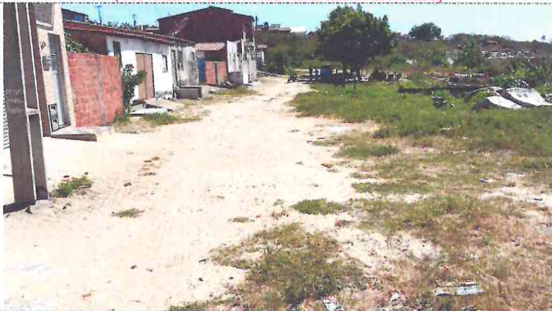
Final (E04 + 13,12m) da RUA JOSÉ GUIMARÃES (Bairro: SÃO JOSÉ) (Coordenada UTM 568665.20 / 9435882.30)
