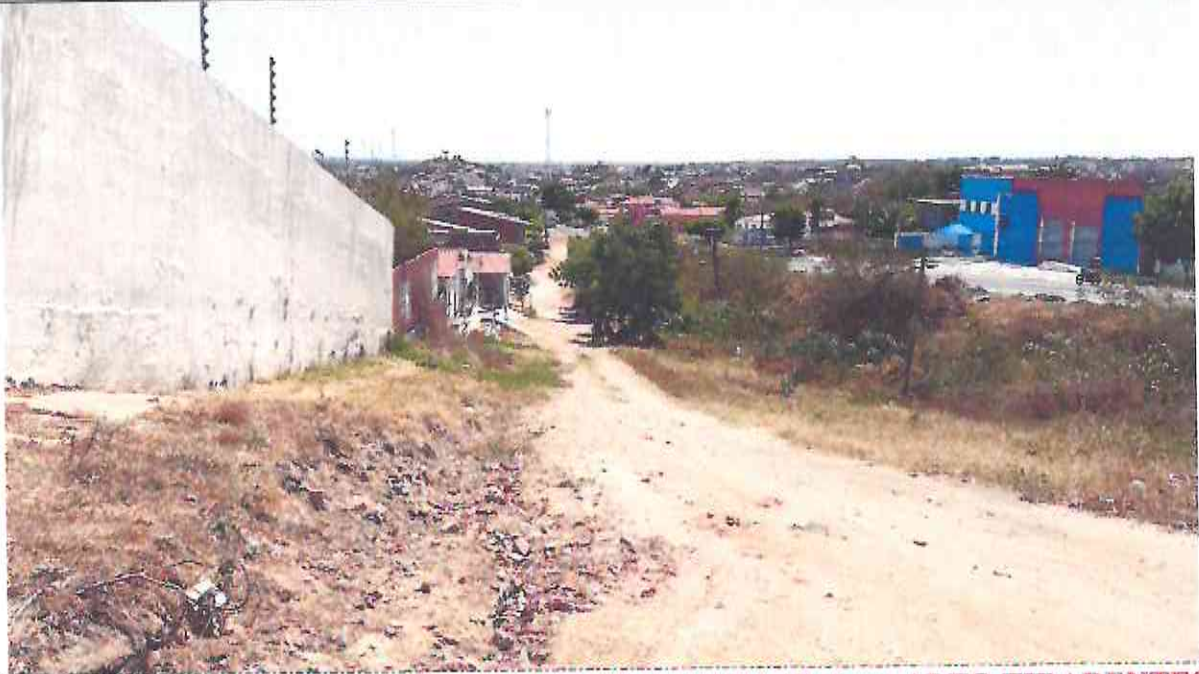
Início (Estaca E00) da RUA JOÃO ANDRADE NANTUA (Bairro: ALTO TIRADENTES) (Coordenada UTM 571310.03 / 9436021.95)
