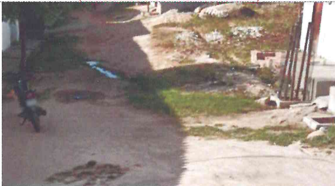
Final (Estaca 04 + 17,16m) do Trecho da RUA JOSÉ LEANDRO DE CASTRO (Bairro: SÃO JOSÉ) (Coordenada UTM 568535.46 / 9435881.41)
