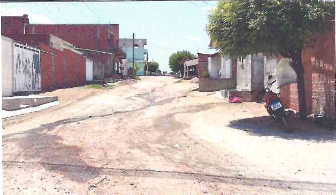
Início (Estaca E00) da RUA PE. FCO. ALVES TEIXEIRA (Bairro: Nossa Senhora da Conceição) (Coordenada UTM 569616.60/9436714.21)
