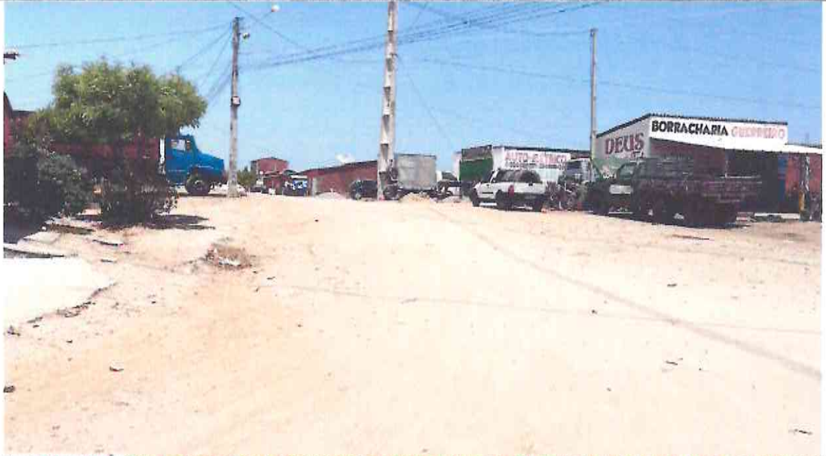
Início (Estaca E00) da RUA RAUL NOGUEIRA (Bairro: ALTO TIRADENTES) (Coordenada UTM 570768.19 / 9435742.57)
