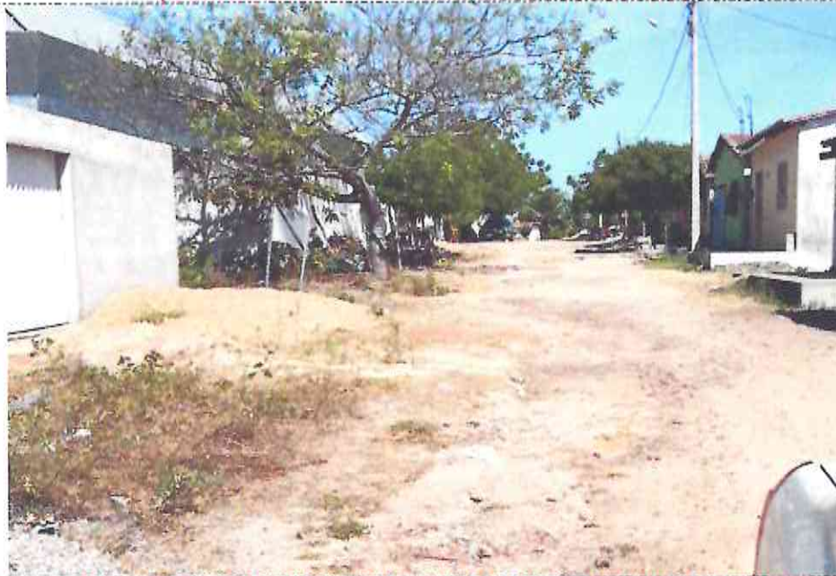
Final (Estaca E07 + 10,00m) da RUA LUIZ BEZERRA DA SILVA (Bairro: SÃO JOSÉ) (Coordenada UTM 568834.52 / 9436225.34)
