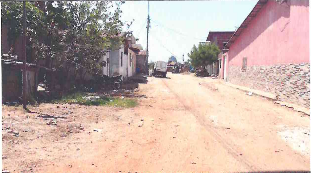
Início (Estaca E00) da TRAVESSA RDO VIANA (Bairro: ALTO TIRADENTES) (Coordenada UTM 571209.75 / 9435832.54)
