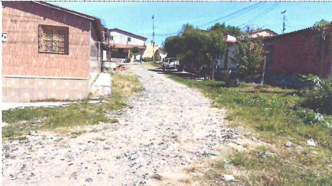
Final (E02 + 5,50m) da RUA CAPITÃO JOSÉ RUFINO (TRECHO II) (Bairro: SÃO JOSÉ) (Coordenada UTM 568691.44 / 9435975.09)
