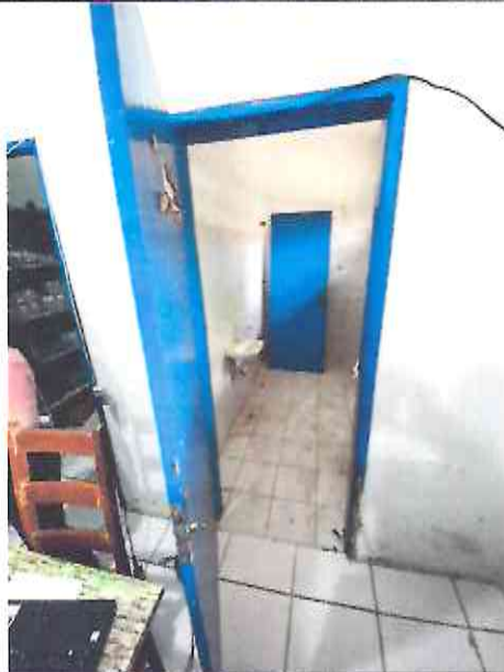
Figura 15 – BANHEIRO DA SALA DE OBSERVAÇÃO
