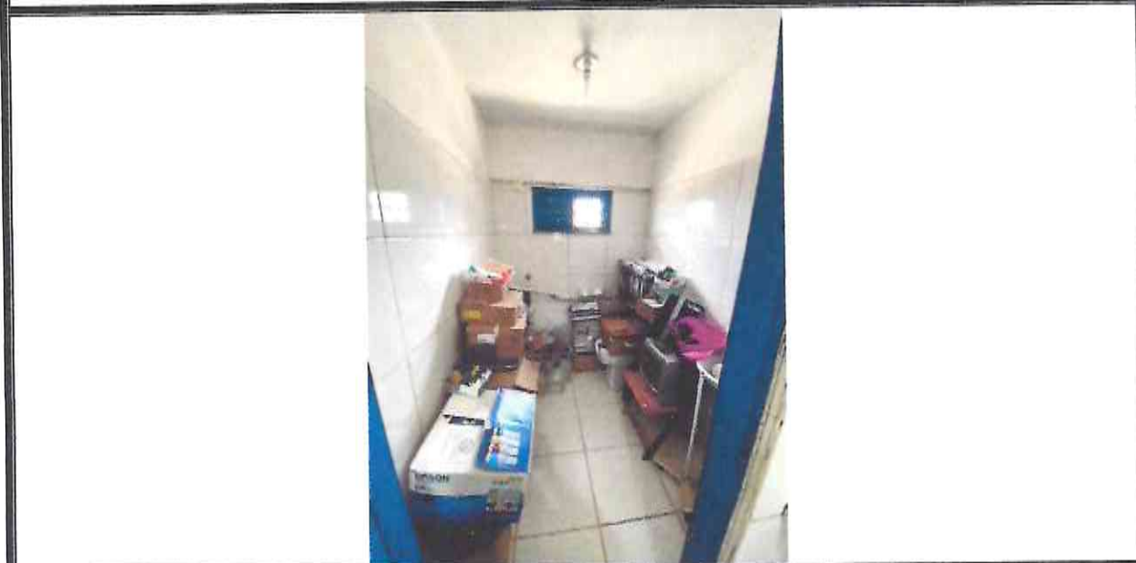
Figura 24 – ACESSO À AMPLIAÇÃO
