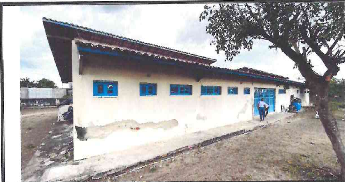
Figura 03- FACHADA POSTERIOR SUL
