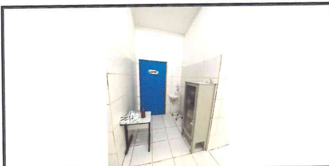
Figura 23 – ACESSO À AMPLIAÇÃO
