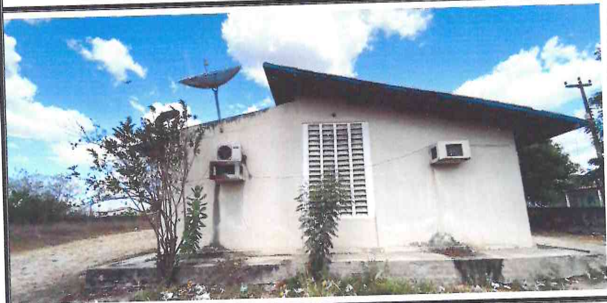
Figura 02- FACHADA LATERAL LESTE
