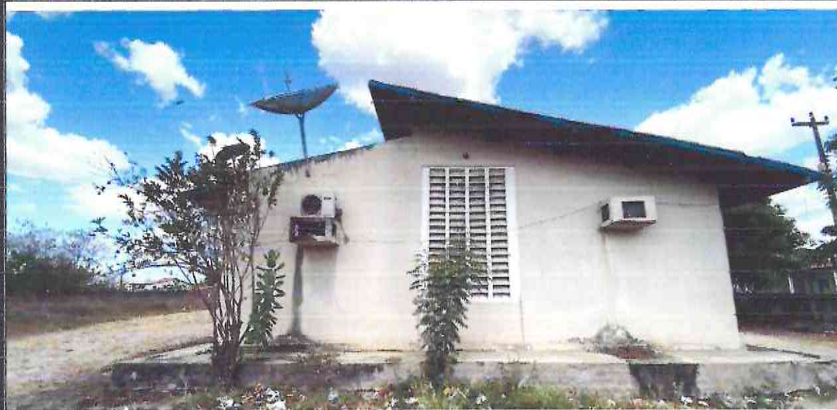
Figura 02- FACHADA LATERAL LESTE
