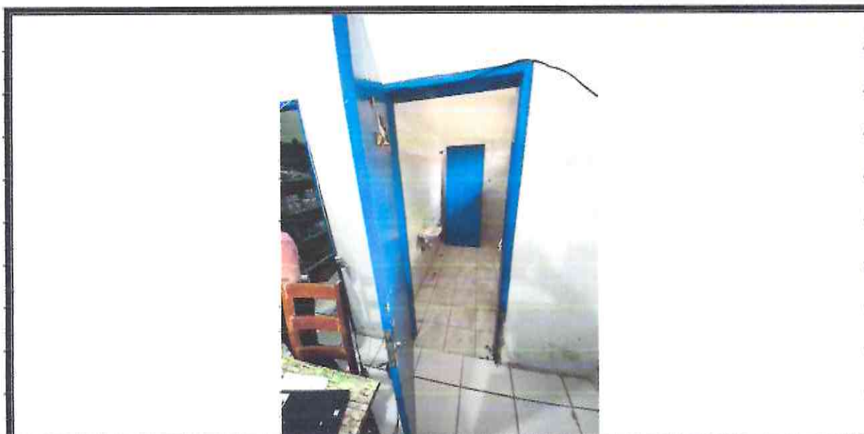
Figura 15 – BANHEIRO DA SALA DE OBSERVAÇÃO
