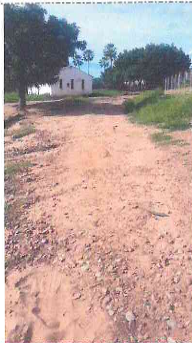
Final (Estaca E18 + 17,60m) RUA SEM DENOMINAÇÃO
