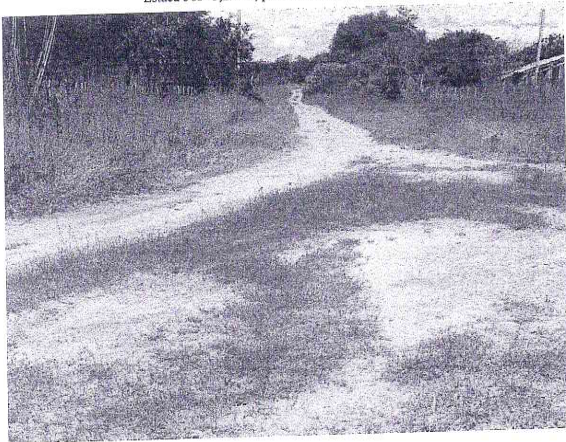
Foto 5: Final da Estrada que liga a localidade Patos a Flores Estaca 563+3,297m, perfazendo um total de 11,26 km.
