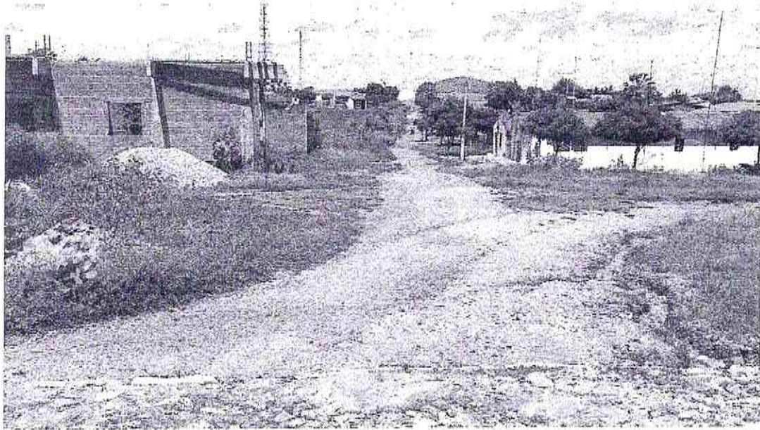
Início (Estaca E00) da Rua Ésau Chaves
