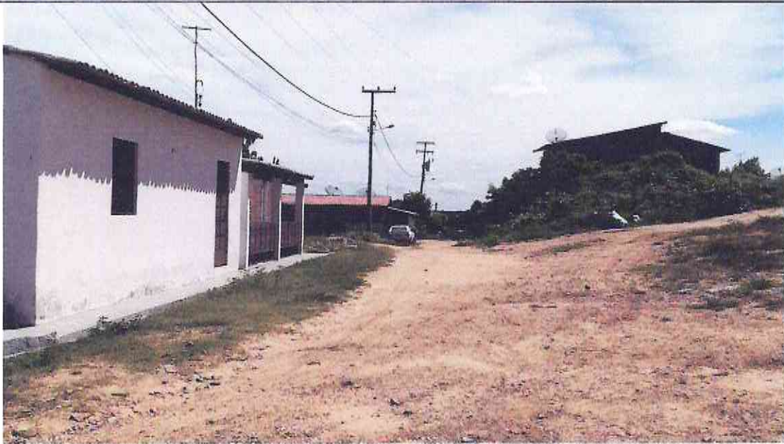
Início (Estaca E00) da Rua José Henrique (Bairro: Henrique Hermógenes Girão) UTM 567801.07/9435894.53
