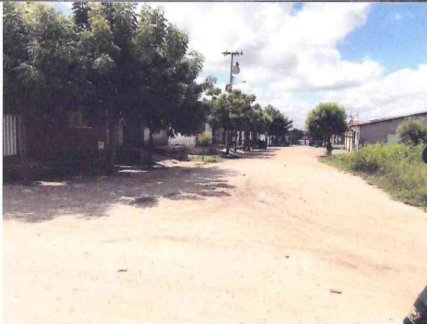
Início (Estaca E00) da Rua Aloizio Furtado Girão (Bairro: Henrique Hermógenes Girão) UTM 567908.07 /9435928.22
