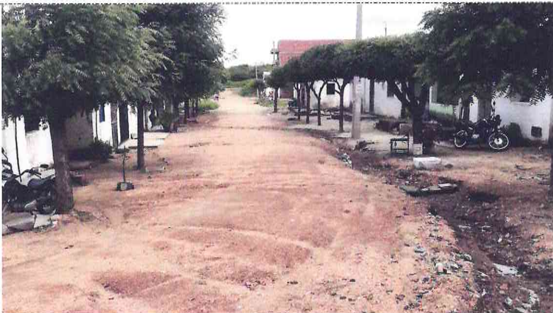
Final (Estaca E07 + 13,91m) da Rua Santa Luzia (Bairro: Henrique Hermógenes Girão) UTM 568083.88/9436036.32
