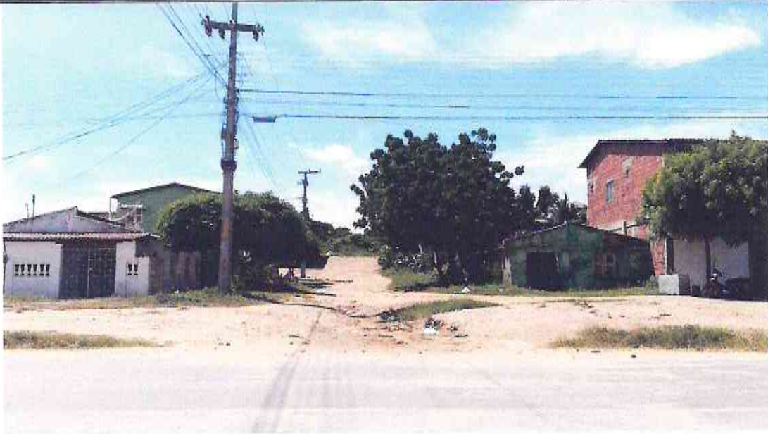
Início (Estaca E00) do Trecho 02 da Rua José Evangelista Sobrinho (Bairro: Henrique Hermógenes Girão) UTM 567789.25 /9435831.08
