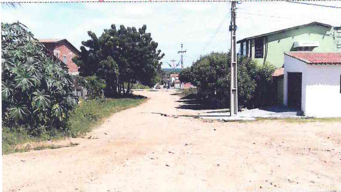
Final (Estaca E03 + 00,45m) do Trecho 02 da Rua José Evangelista Sobrinho (Bairro: Henrique Hermógenes Girão) UTM 567797.11/9435891.01
