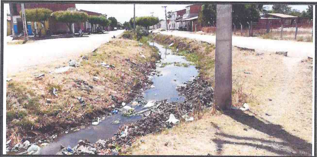
Figura 01- Início do Canteiro 1- UTM: 569303.59/9434769.00
