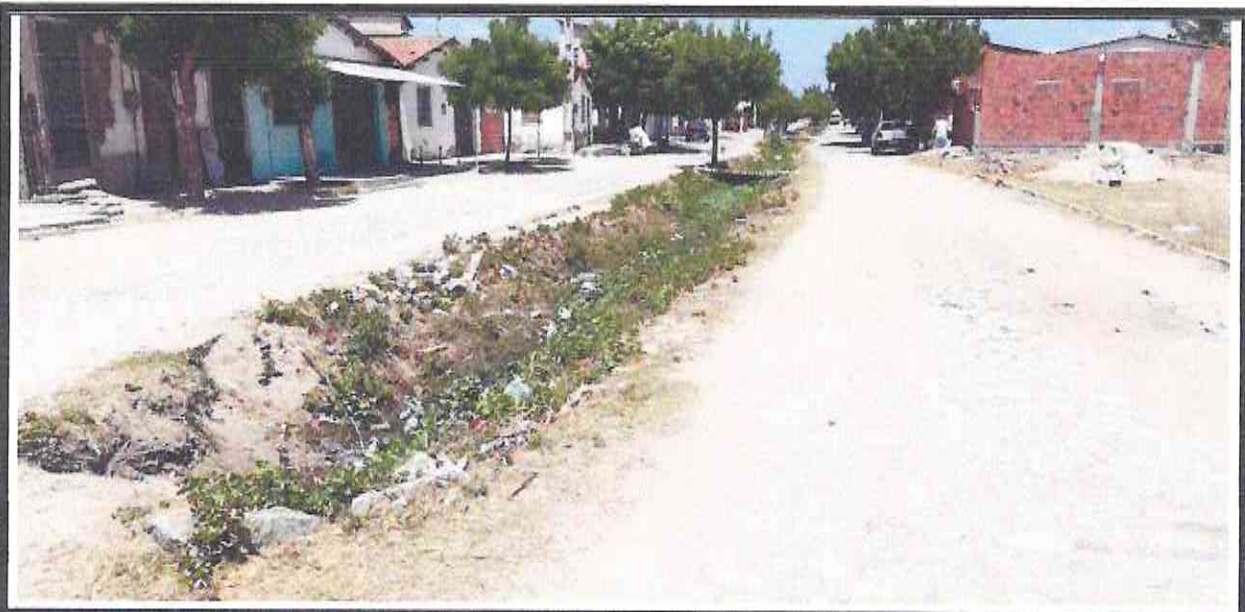
Figura 07- Início do Canteiro 4- UTM: 569741.28/9434674.10
