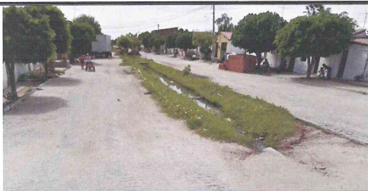
Figura 03- Início do Canteiro 2- UTM: 569450.63/9434735.87
