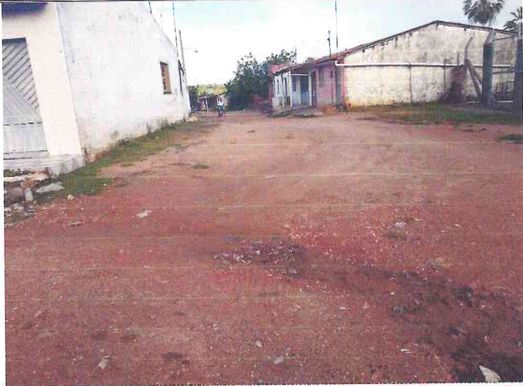
Início (Estaca E00) da Rua Pedro Martins da Costa (Coordenada UTM 554713.00/9468158.00)
