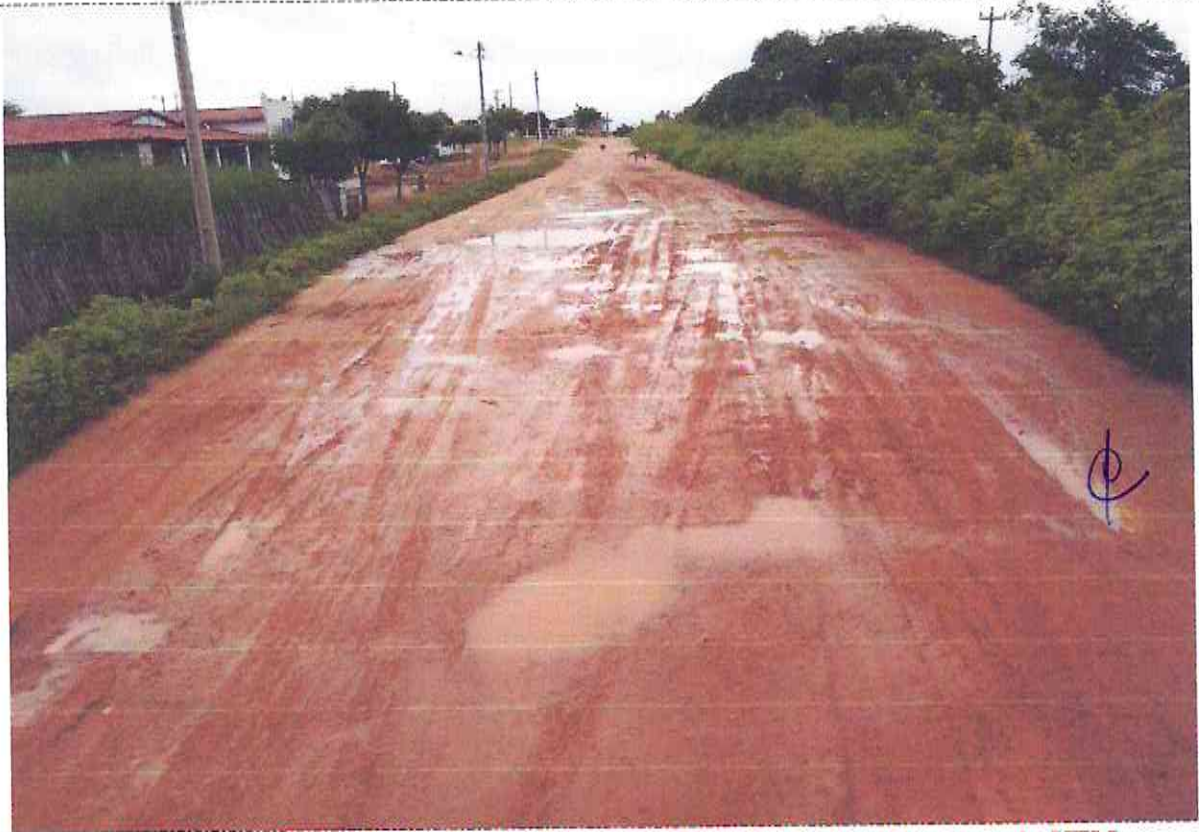
Final (Estaca E23 + 17,11m) da Rua Francisco Ferreira Nobre (Coordenada UTM 554972.58/9467626.45)
