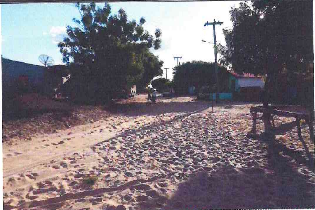
Início (Estaca E00) da Rua Sem Denominação (Localidade: Lagoa das Carnaúbas) UTM 0546467.94 / 9438772.02
