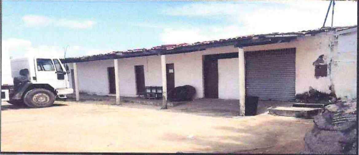
Figura 01- Fachada do prédio que funcionará o almoxarifado da prefeitura de Morada Nova- CE
