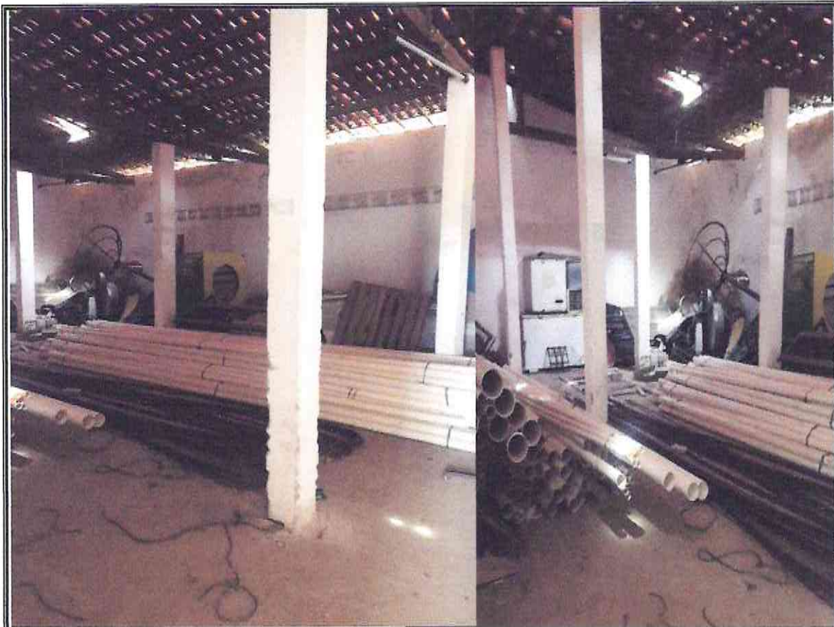
Figura 03- Pilares e cobertura que serão conservados no prédio
