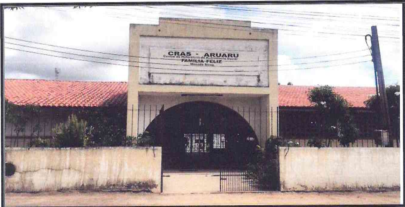
Figura 01- Fachada do CRAS no distrito de Aruaru de Morada Nova-CE
