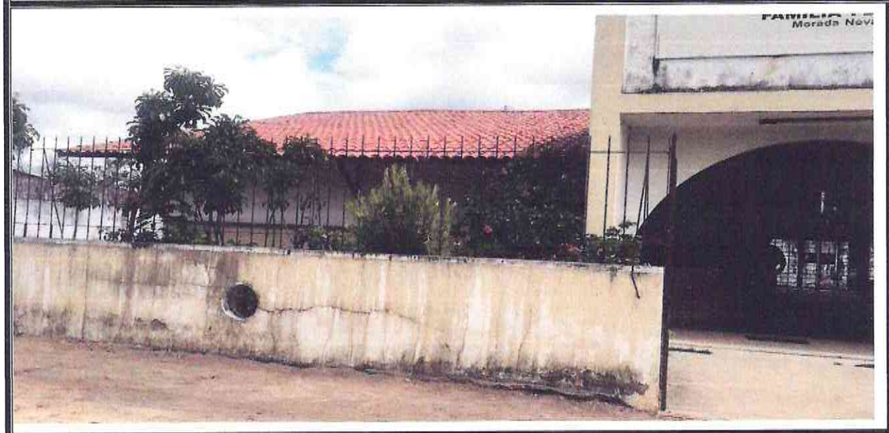
Figura 02- Fachada do CRAS no distrito de Aruaru de Morada Nova-CE
