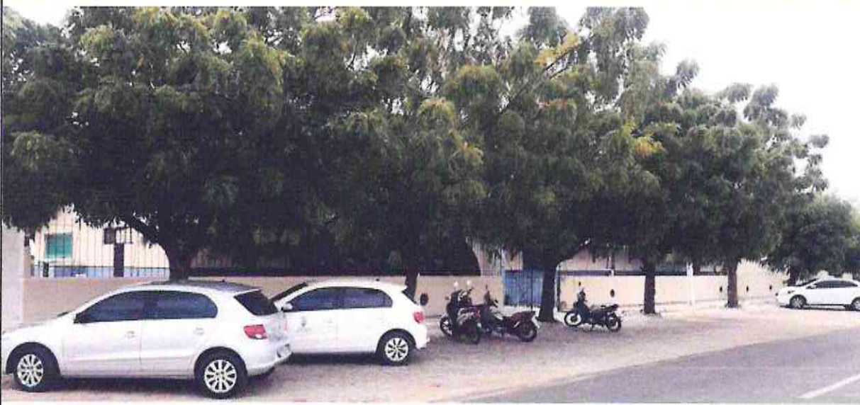
Figura 02- Fachada ao sul do CRAS de Morada Nova-CE
