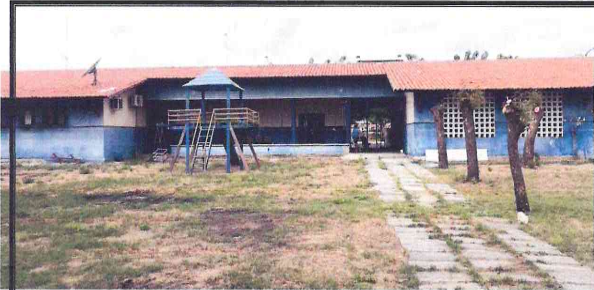
Figura 03- Fachada ao norte do CRAS de Morada Nova-CE
