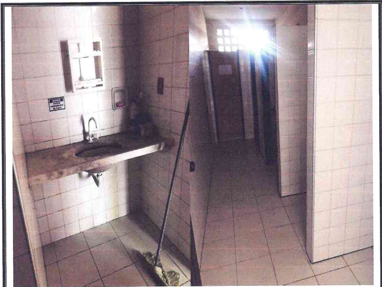
Figura 07- Banheiro masculino do CRAS
