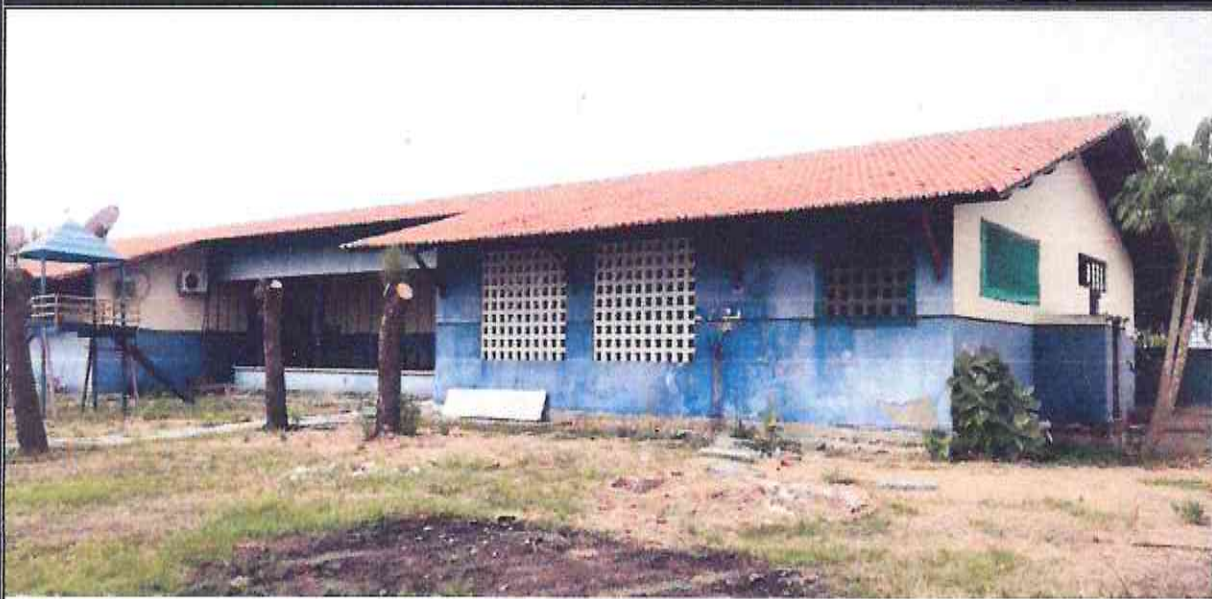
Figura 04- Fachada ao leste do CRAS de Morada Nova-CE
