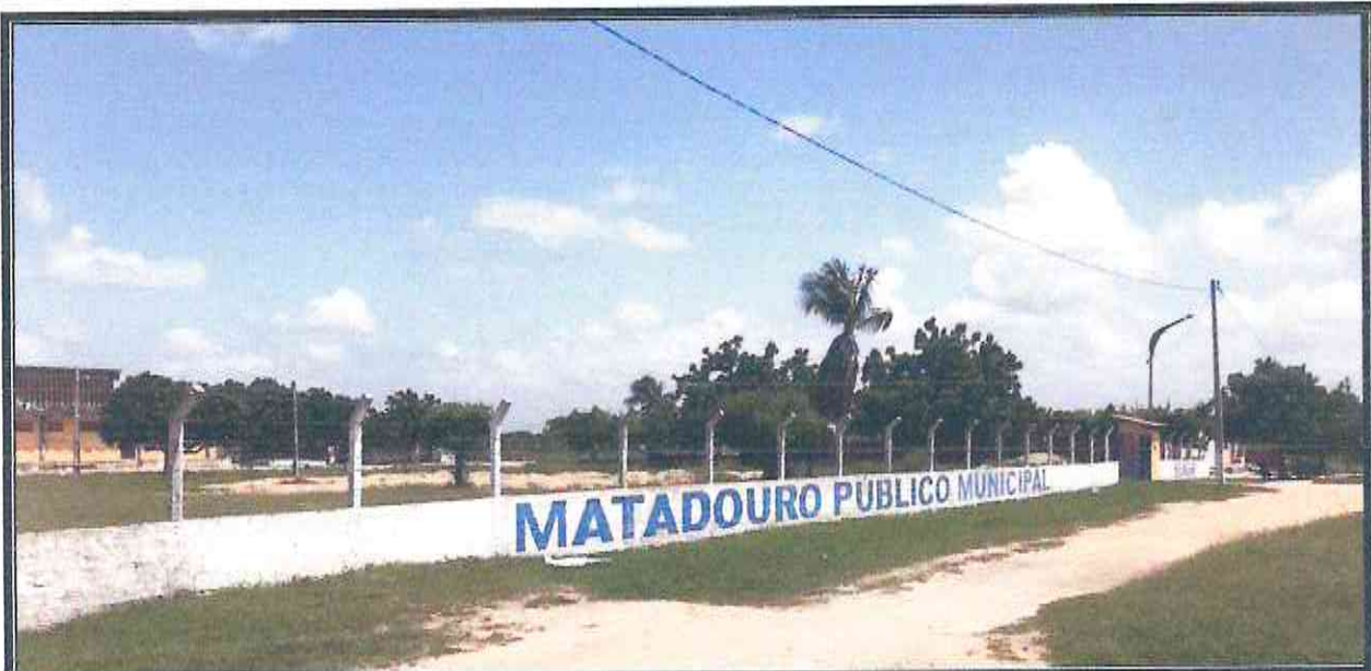
Figura 01- Muro do abatedouro de Morada Nova-CE
