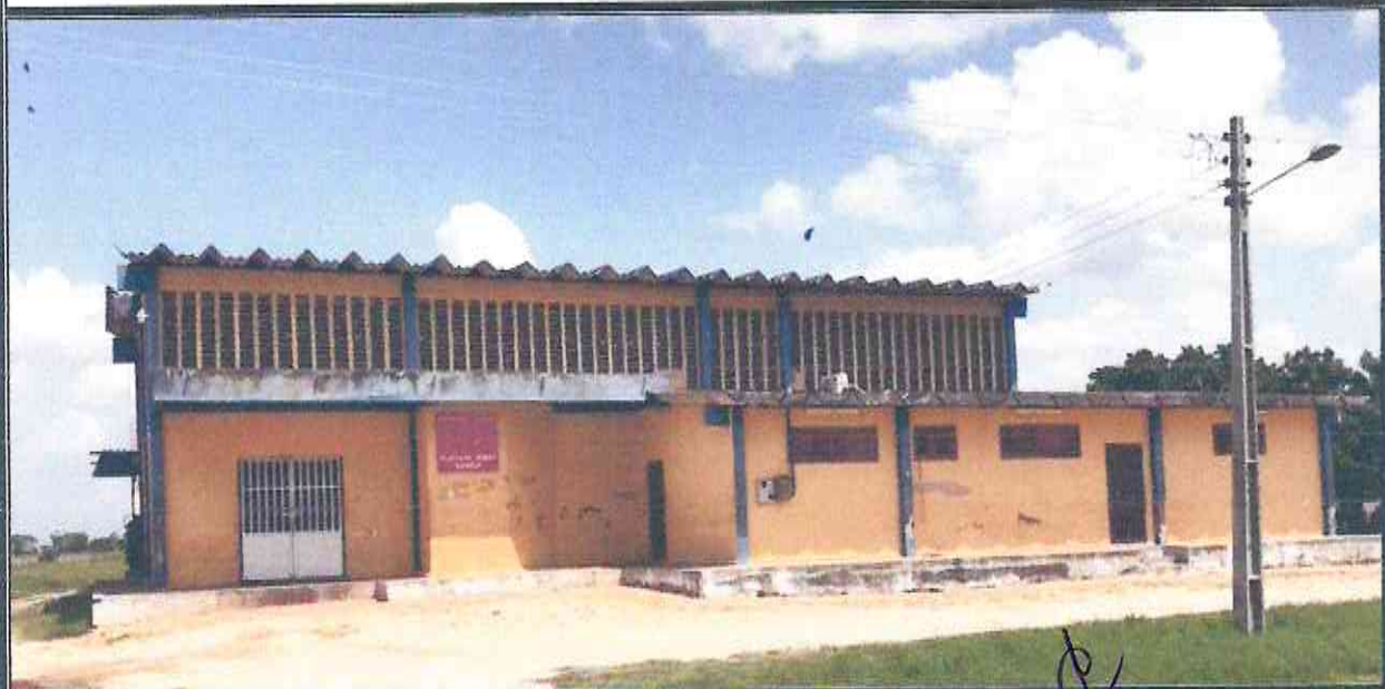
Figura 02- Fachada do abatedouro de Morada Nova-CE
