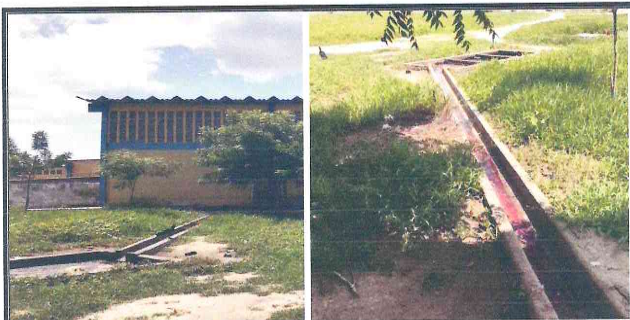
Figura 03- Sistema de esgotamento sanitário a ser substituído
