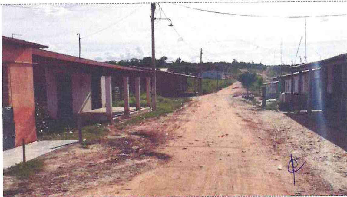
Final (Estaca E11 + 14,00 m) da Rua Abel Martins da Costa (Coordenada UTM 554328.00/9468113.00)
