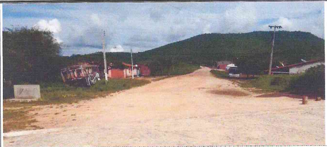
Início (Estaca E00) da Rua Francisco Ferreira Nobre (Coordenada UTM 554727.00/9468031.00)
