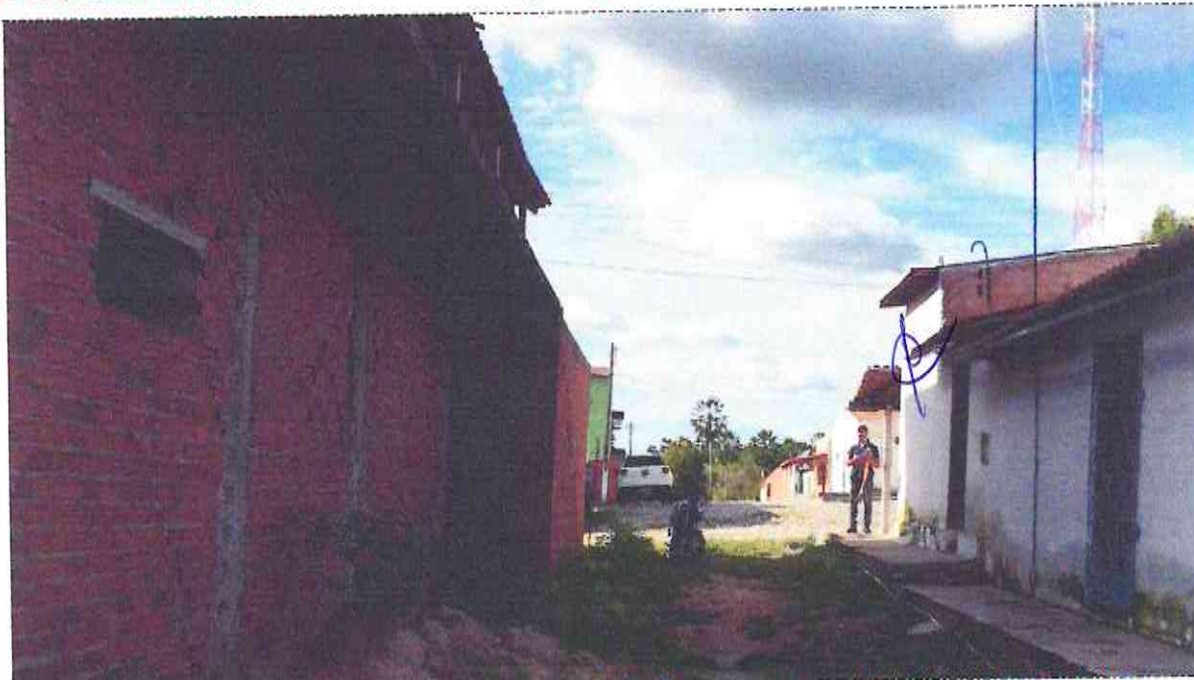
Final (Estaca E00 + 18,00m) da Travessa Luiz Gonzaga Fagundes (Coordenada UTM 554616.00/9468041.00)
