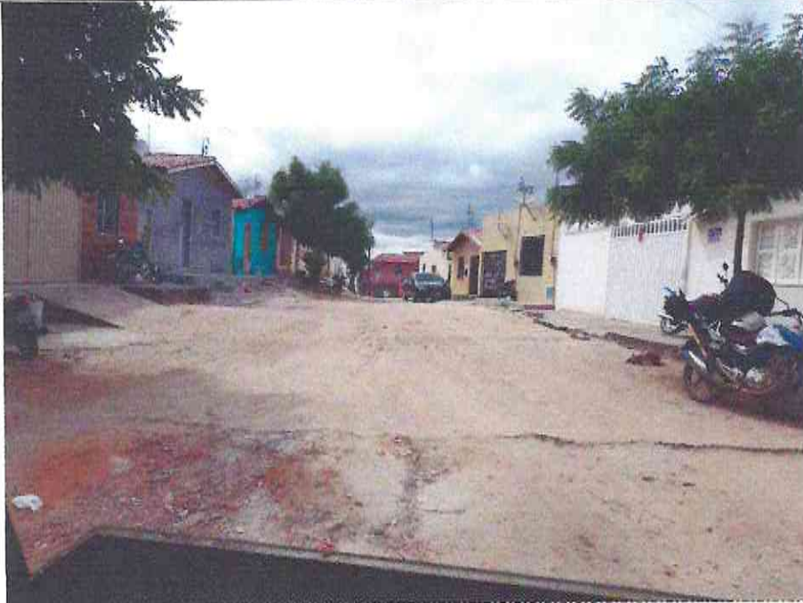
Início (Estaca E00) da Rua Melício Viana (Bairro: São Francisco) (Coordenada UTM 569611.81/9436242.27)
