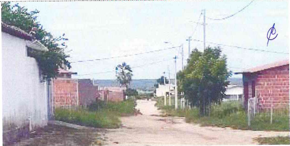
Final (Estaca E06 + 1,55m) Trecho da Rua José Carneiro Filho (Bairro: Vazantes) (Coordenada UTM 573854.65/9436209.01)
