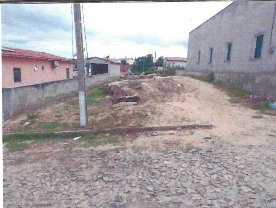
Início (Estaca E00) do Trecho da Rua Henrique Marinheiro (Bairro: São Francisco) (Coordenada UTM 570150.28/9435965.24)
