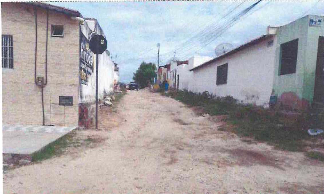
Final (Estaca E06 + 05,70m) da Rua Melício Viana (Bairro: São Francisco) (Coordenada UTM 569686.88/9436242.21)
