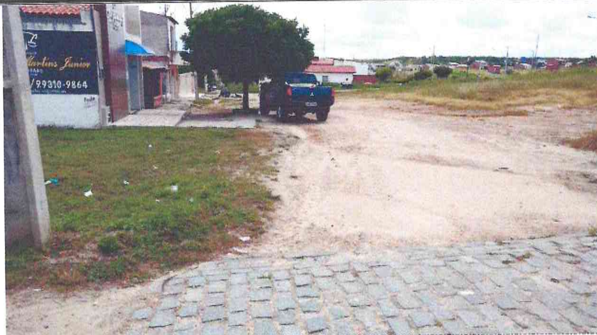
Início (Estaca E00) da Rua Aluizio Gonzaga De Lima (Bairro: 02 de Agosto) (Coordenada UTM 570596.55/9435387.95)
