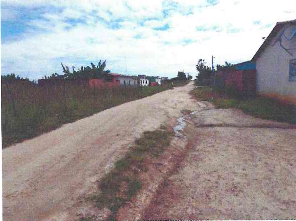
Início (Estaca E00) do Trecho da Rua José Carneiro Filho (Bairro: Vazantes) (Coordenada UTM 573853.08/9436087.56)
