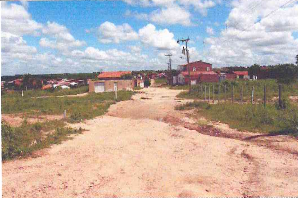
Início (Estaca E00) do Trecho da Rua Dr. Roberto Hugo (Bairro: Nova Morada) (Coordenada UTM 570425.14/9436381.26)
