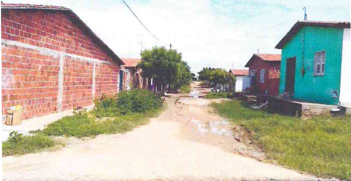
Início (Estaca E00) da Rua Raimundo Marcelino Cavalcante (Bairro: Vazantes) (Coordenada UTM 573987.85/9436141.33)
