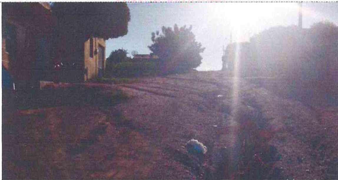
Final (Estaca E06 + 09,68m) do Trecho da Rua Zeca Nobre (Bairro: Nova Morada) UTM 570784.05/9436653.62
