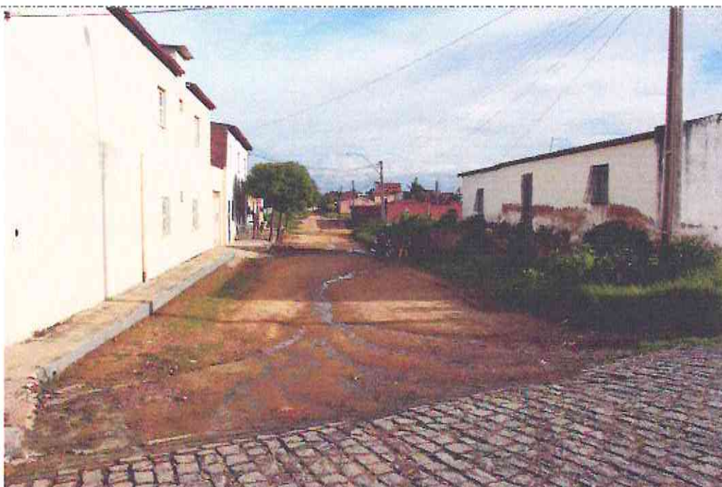
Final (Estaca E11 + 12,00m) da Rua Duque Rabelo (Bairro: 2 De Agosto) UTM 570160.21/9435574.01
