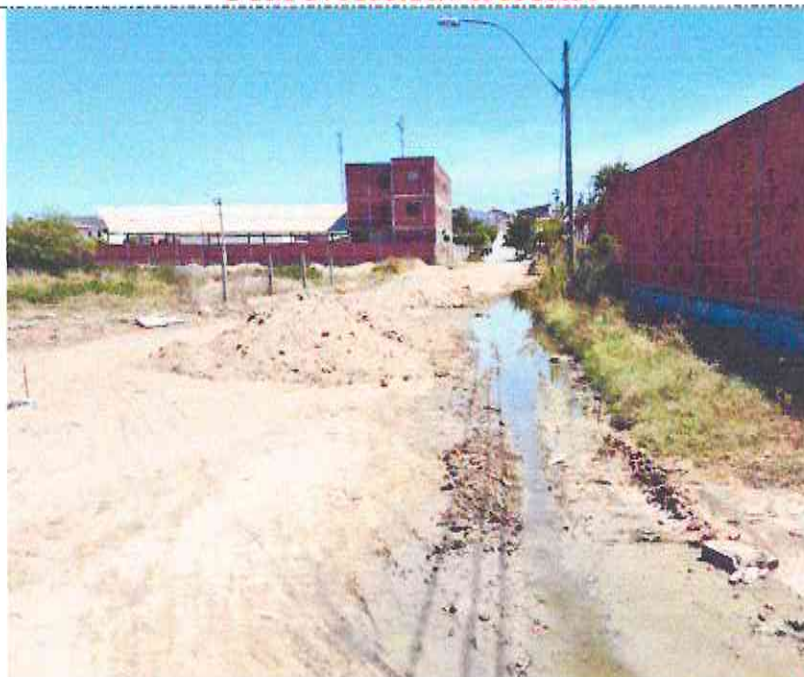
Final (Estaca E08 + 2,12m) da Rua Joaquim Chagas Filho (Bairro: 2 De Agosto) UTM 570248.52/9435503.28
