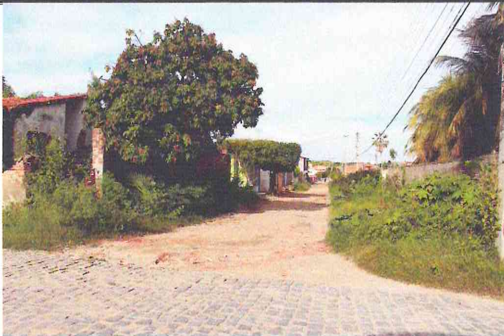
Início (Estaca E00) do Trecho da Rua Benício Chagas (Bairro: 2 De Agosto) UTM 569960.93/9435476.78
