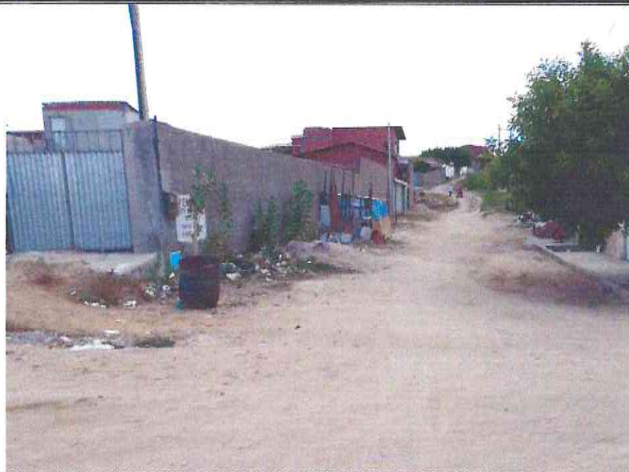
Início (Estaca E00) do Trecho da Rua Egídia Muniz Zacarias (Bairro: São Francisco) UTM 570064.00 /9436266.49
