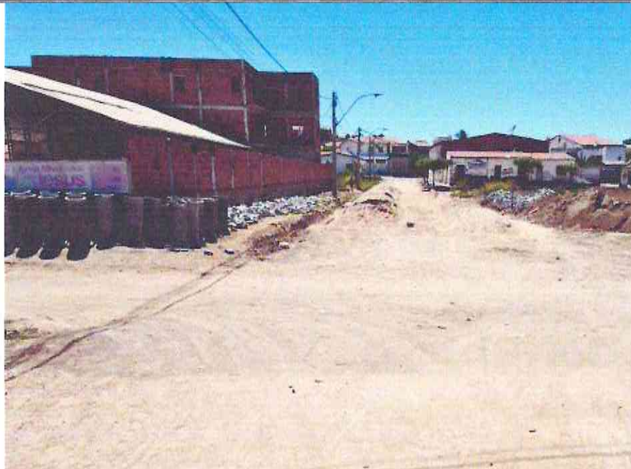
Início (Estaca E00) da Rua Duque Rabelo (Bairro: 2 De Agosto) UTM 570129.59/9435344.31
