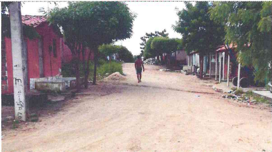
Final (Estaca E06 + 14,67m) da Rua Henrique Girão (Bairro: Henrique Hermógenes Girão) UTM 567602.38/9435457.18
