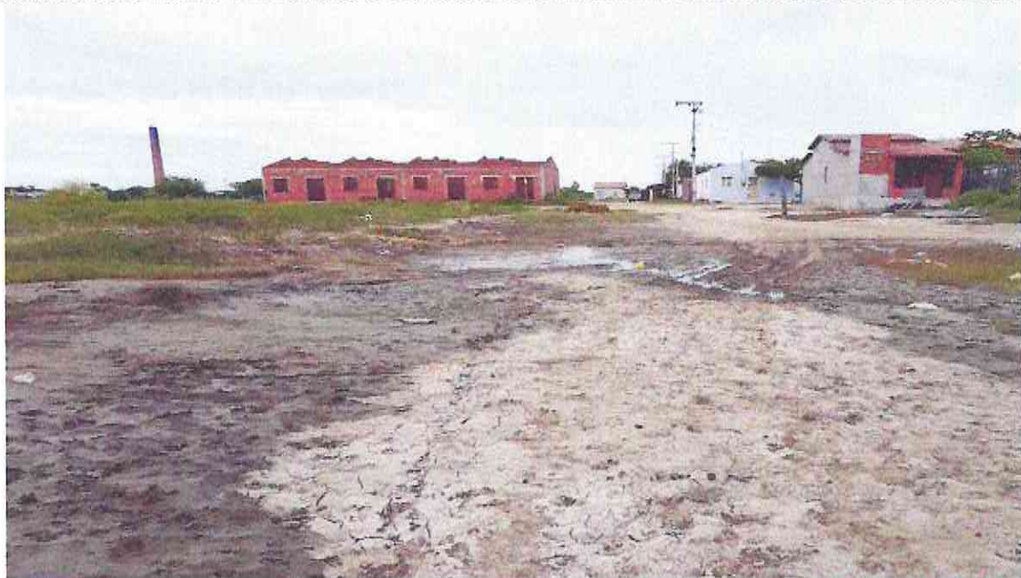
Final (Estaca E06 + 2,86m) do Trecho da Rua Luiz Adail Chagas (Bairro: Padre Assis Monteiro) UTM 569096.00/9435368
