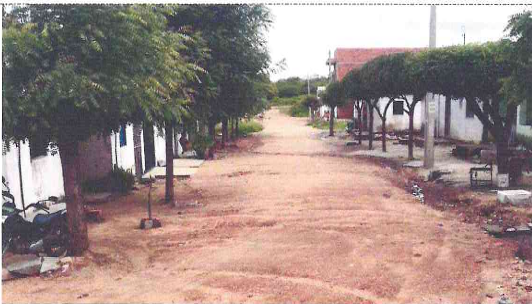
Final (Estaca E07 + 13,91m) da Rua Santa Luzia (Bairro: Henrique Hermógenes Girão) UTM 568083.88/9436036.32
