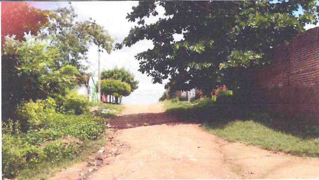
Início (Estaca E00) da Rua Conrado Machado (Bairro: Henrique Hermógenes Girão) UTM 567759.99/9435563.76
