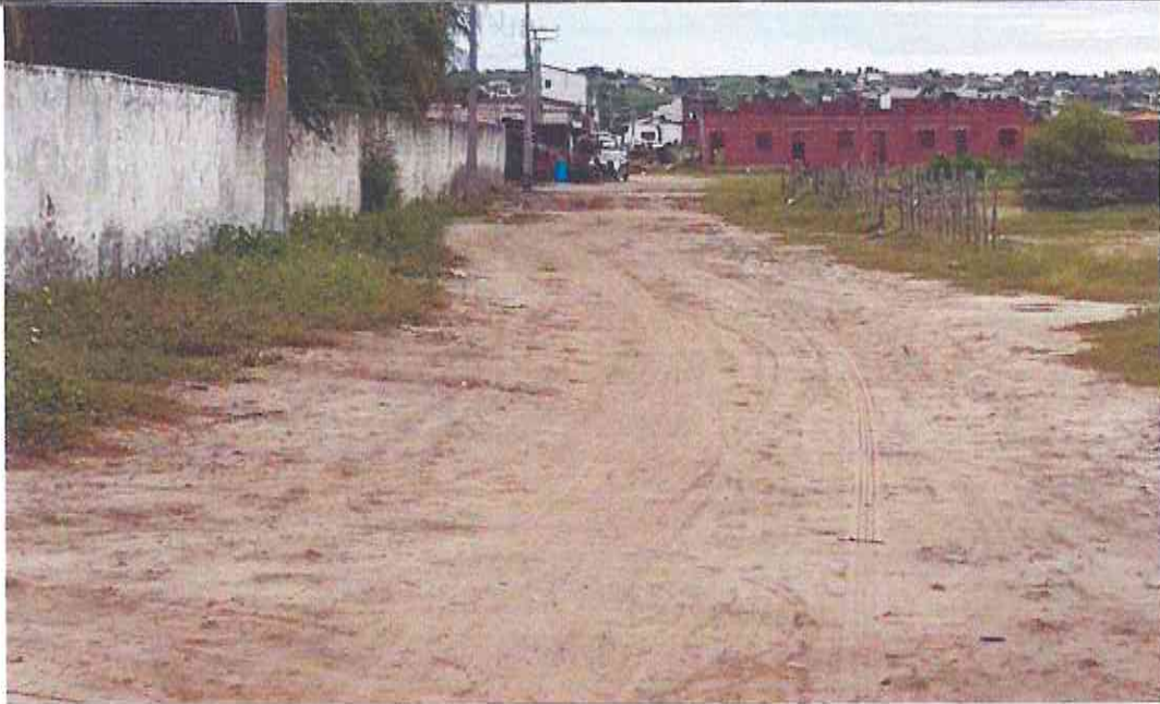
Início (Estaca E00) do Trecho da Rua Luiz Adail Chagas (Bairro: Padre Assis Monteiro) UTM 569064.00 /9435252.00
