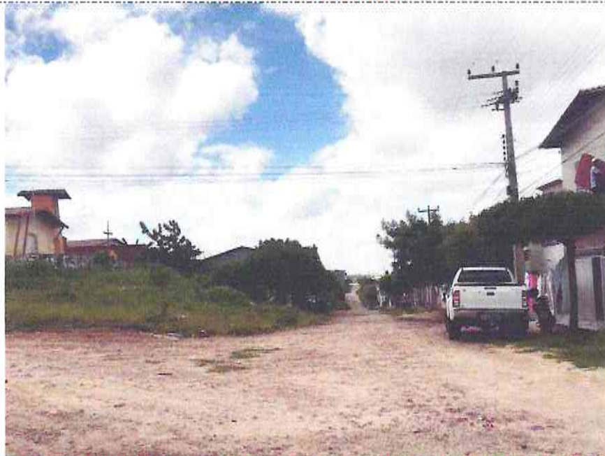
Final (Estaca E21 + 18,27m) da Rua Cel. José Paulo Girão (Bairro: Henrique Hermógenes Girão) UTM 567863.71/9435839.05
