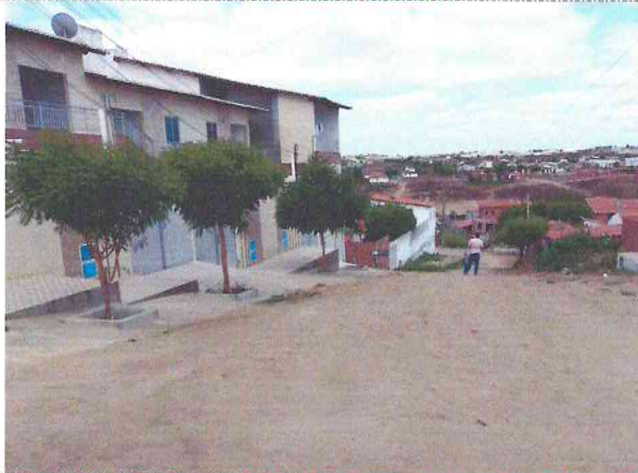
Final (Estaca E10 + 4,71m) do Trecho da Rua Egídia Muniz Zacarias (Bairro: São Francisco) UTM 570234.85/9436155.92
