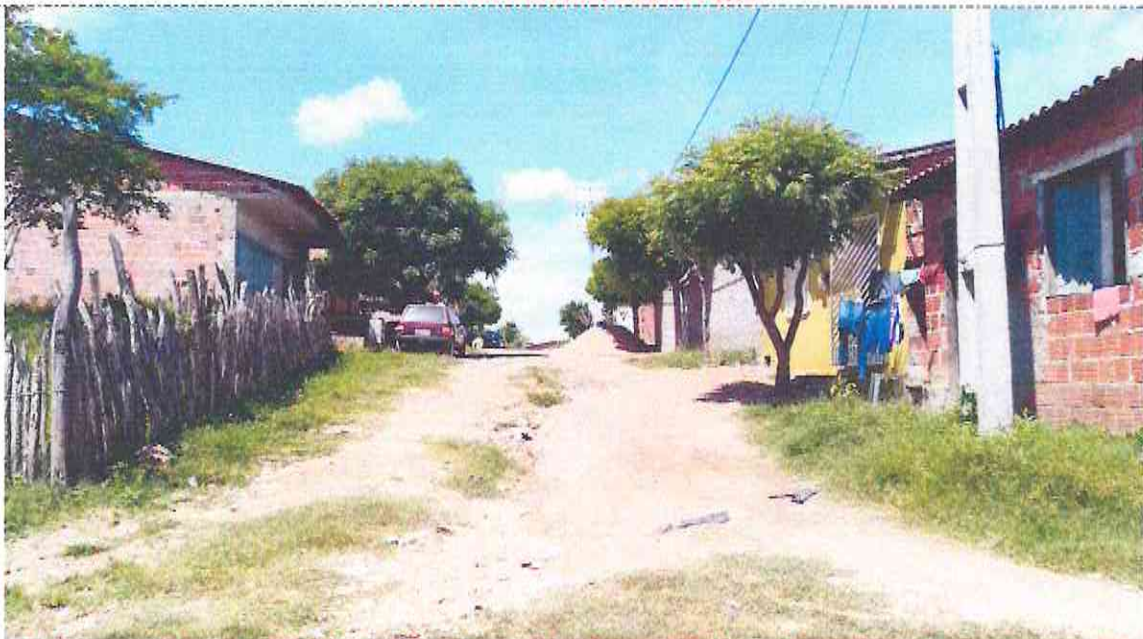
Final (Estaca E14 + 14,71m) da Rua José Henrique (Bairro: Henrique Hermógenes Girão) UTM 567667.49/9435911.93
