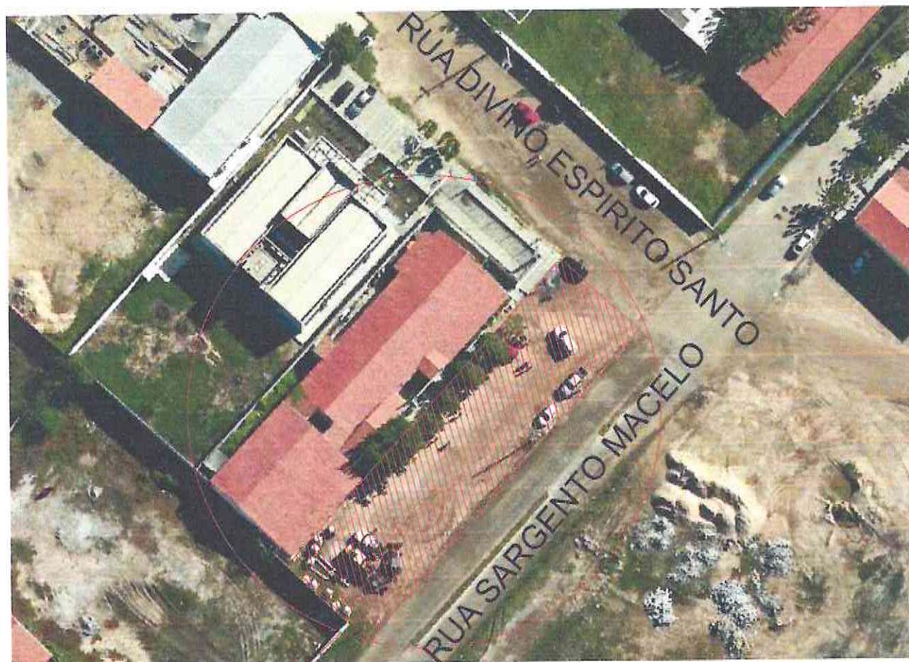
Local da Obra
