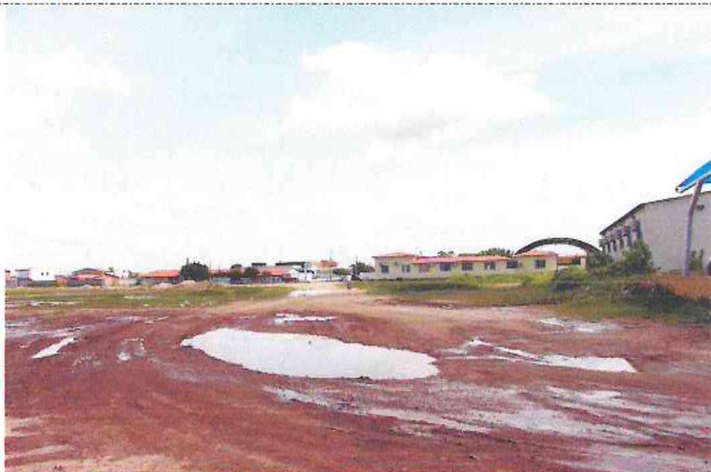
Final (Estaca E14 + 5,19m) do Trecho da Rua Divino Espirito Santo (Bairro: Padre Assis Monteiro)
