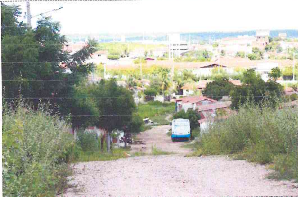
Final (Estaca E10 + 14,00m) do Trecho da Rua Hélio Maia (Bairro: Nova Morada)
