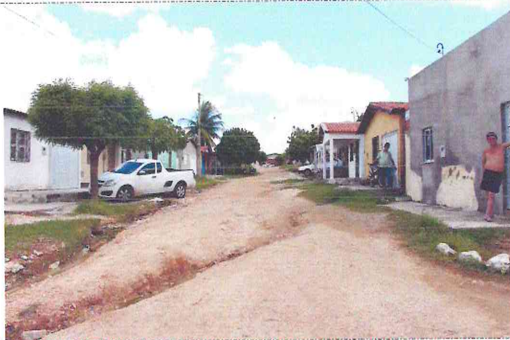
Final (Estaca E10 + 12,00m) do Trecho da Rua Marechal Deodoro (Bairro: Nova Morada)
