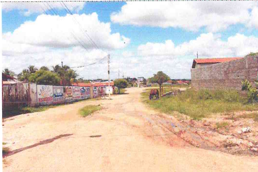
Final (Estaca E09) do Trecho 1 da Rua Juscelino Kubitschek (Bairro: Nova Morada)
