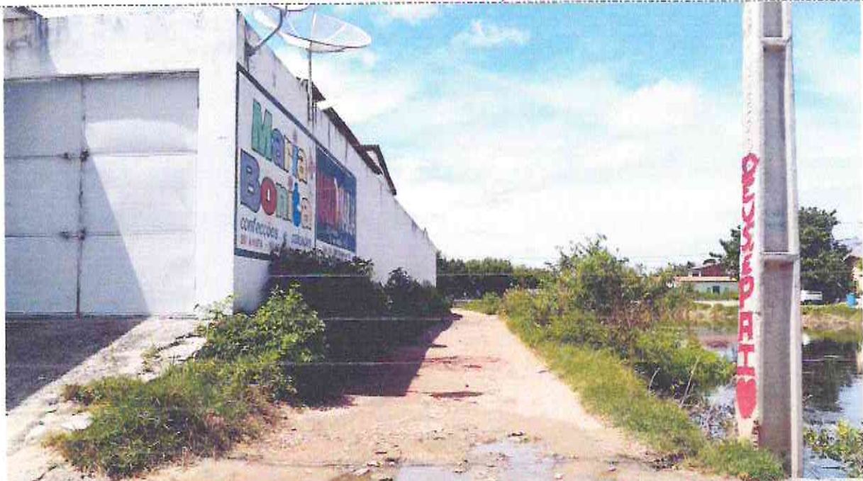
Final (Estaca E13 + 3,50m) da Rua SDO 01 (Ao Lado Do Canal Da Av. Antônio De Castro) (Bairro: Padre Assis Monteiro)
