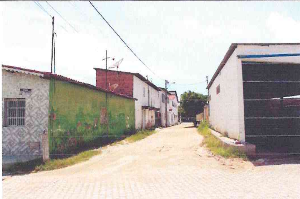
Início (Estaca E00) da Rua Antônio Rubens Da Silva (Bairro: Padre Assis Monteiro)
