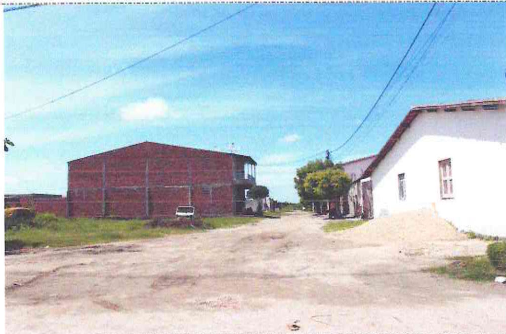
Final (Estaca E07) do Trecho da Rua Raimundo Belmino (Bairro: Padre Assis Monteiro)
