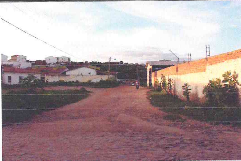
Início (Estaca E00) do Trecho da Rua João Sebastião e Silva (Bairro: São José)
