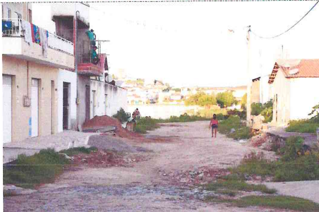
Final (Estaca E03 + 14,40m) do Trecho da Rua José De Castro (Bairro: São José)
