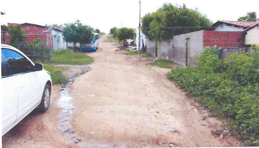
Início (Estaca E00) do Trecho da Rua Hélio Maia (Bairro: Nova Morada)
