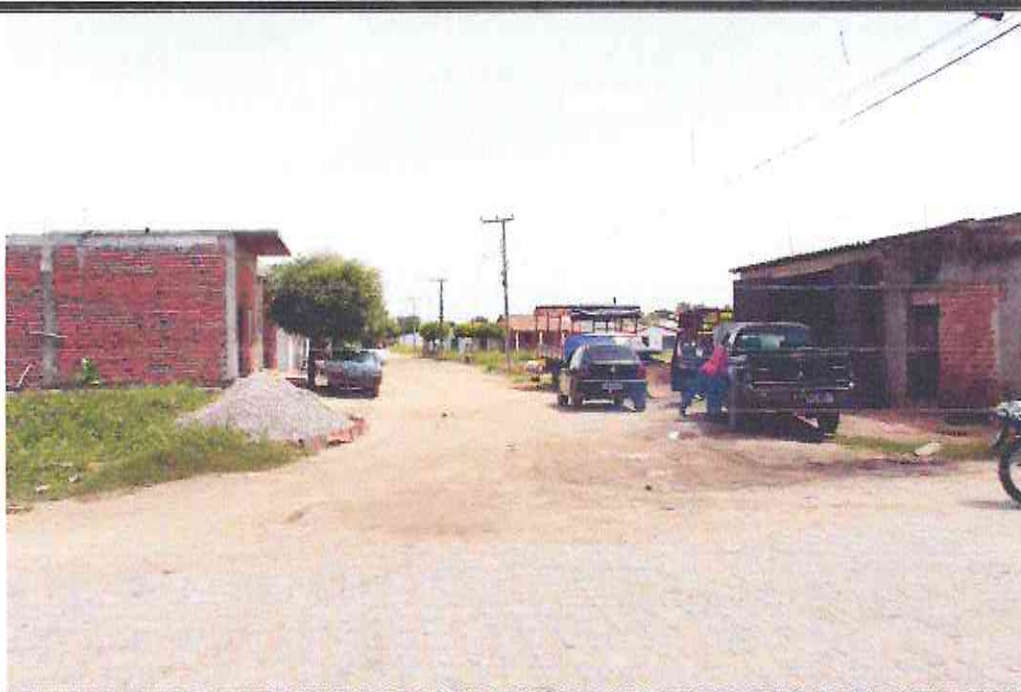
Início (Estaca E00) do Trecho da Rua Nossa Senhora Das Graças (Bairro: Padre Assis Monteiro)
