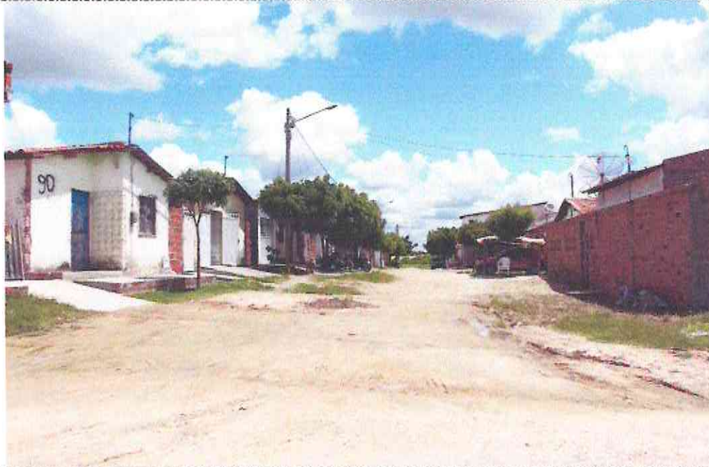
Final (Estaca E05 + 2,00m) da Rua 19 De Março (Bairro: Planalto Aeroporto)
