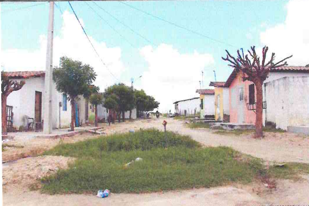
Início (Estaca E00) da Rua Vicente De Paula (Bairro: Planalto Aeroporto)
