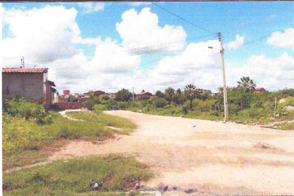
Início (Estaca E00) da Rua Vila Bezerra (Bairro: São José)
