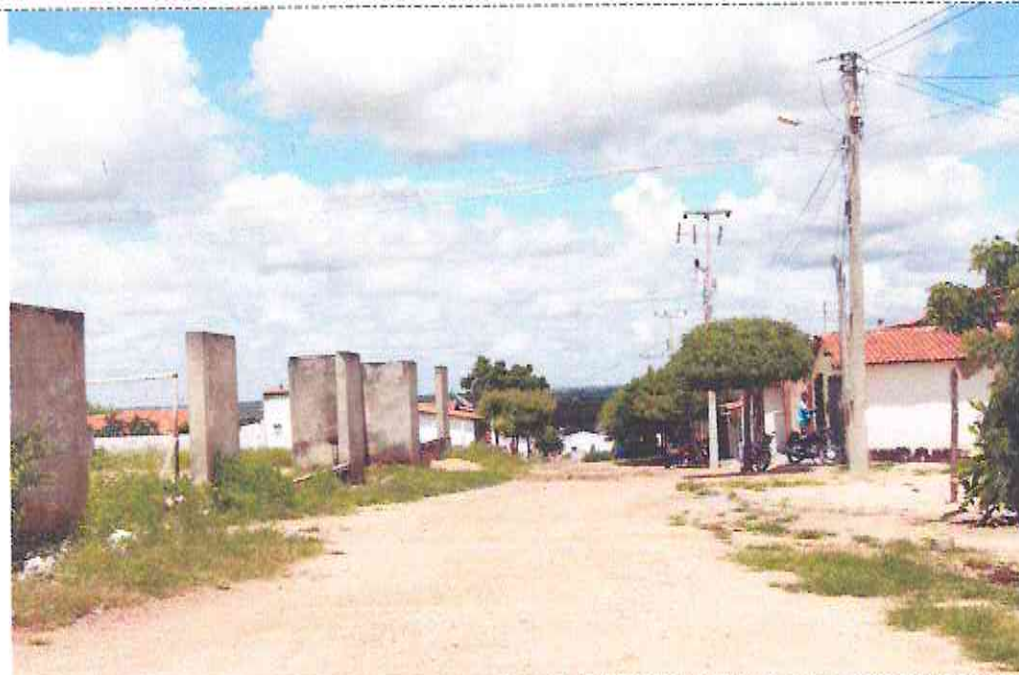
Final (Estaca E06 + 5,00m) da Rua Raimundo Carneiro Girão (Bairro: São José)
