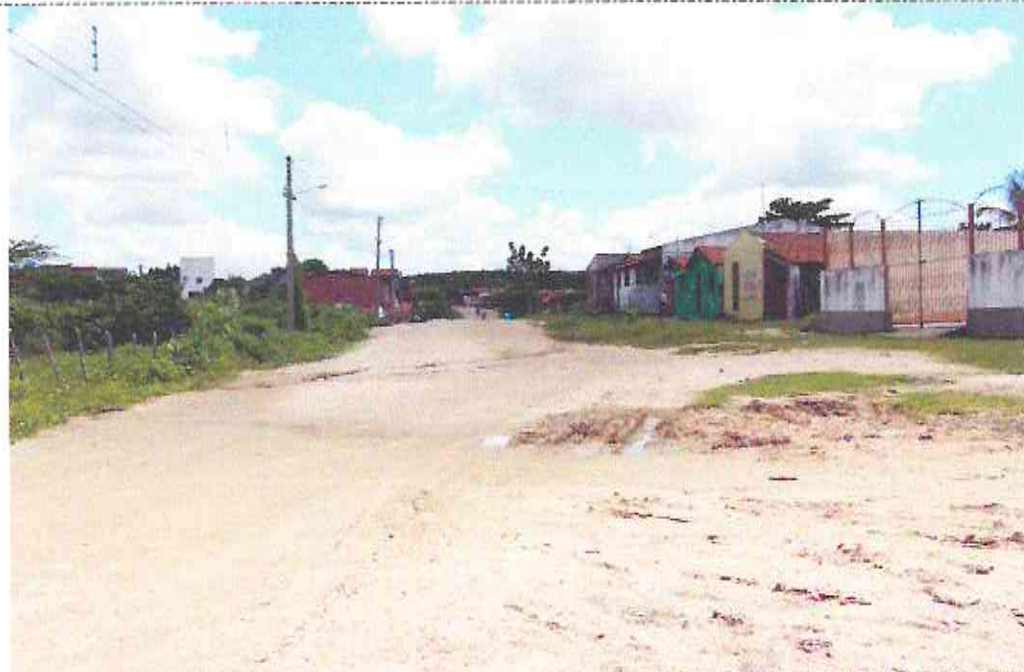
Final (Estaca E14 + 10,00m) da Rua Vila Bezerra (Bairro: São José)
