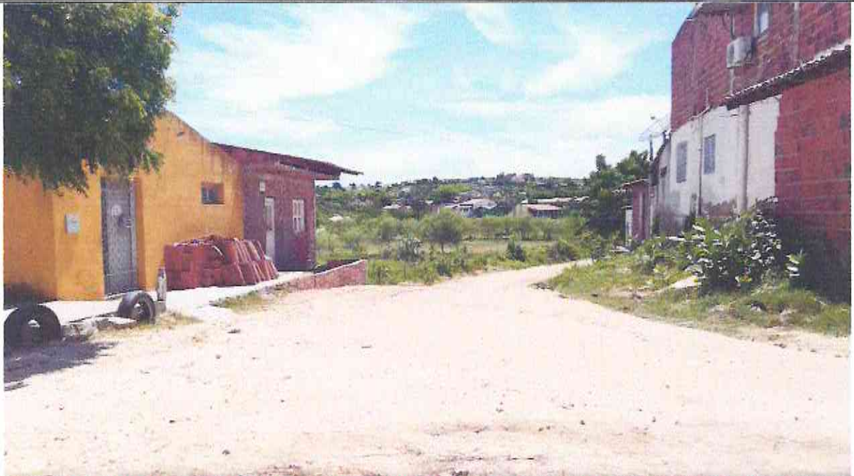
Início (Estaca E00) da Avenida Dom Aluizo A. Dos Santos (Bairro: São José)
