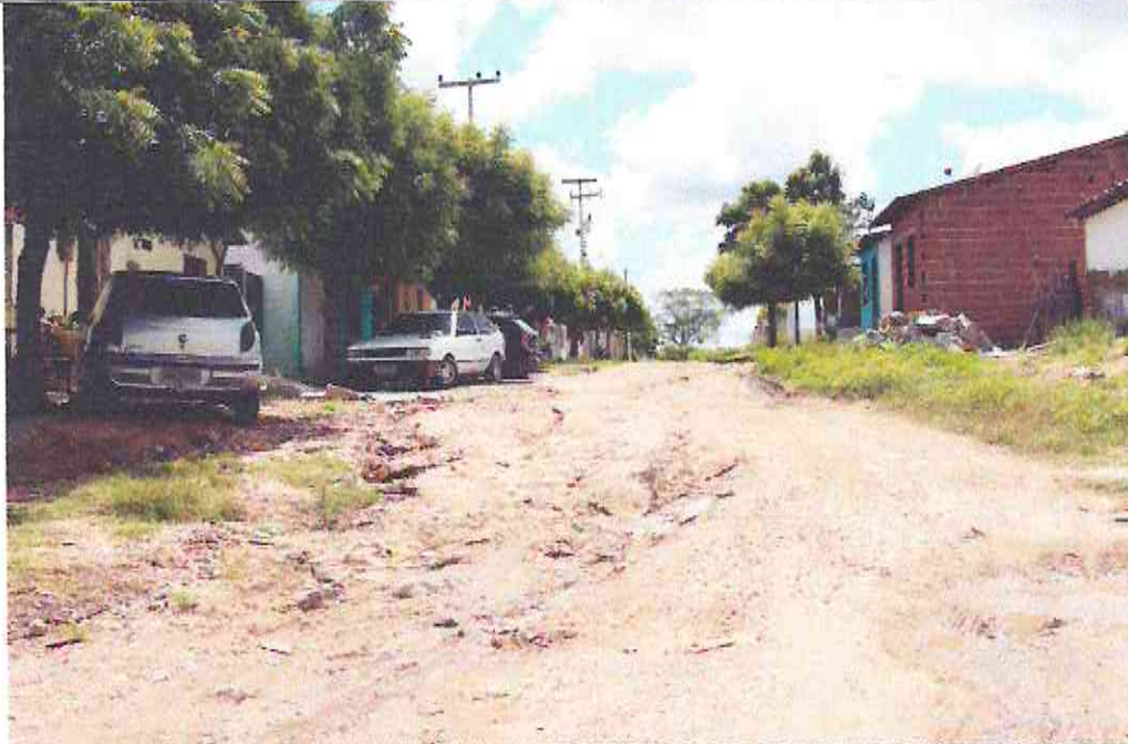
Início (Estaca E00) da Rua Raimundo Carneiro Girão (Bairro: São José)
