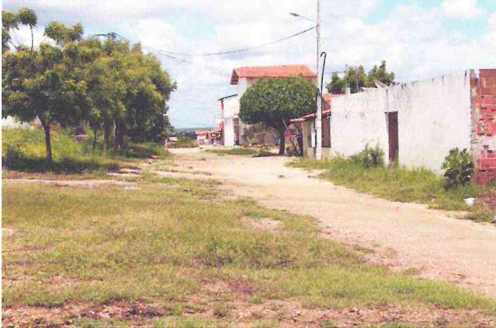
Final (Estaca E08 + 15,00m) da Rua Joaquim Lira Saraiva (Bairro: São José)
