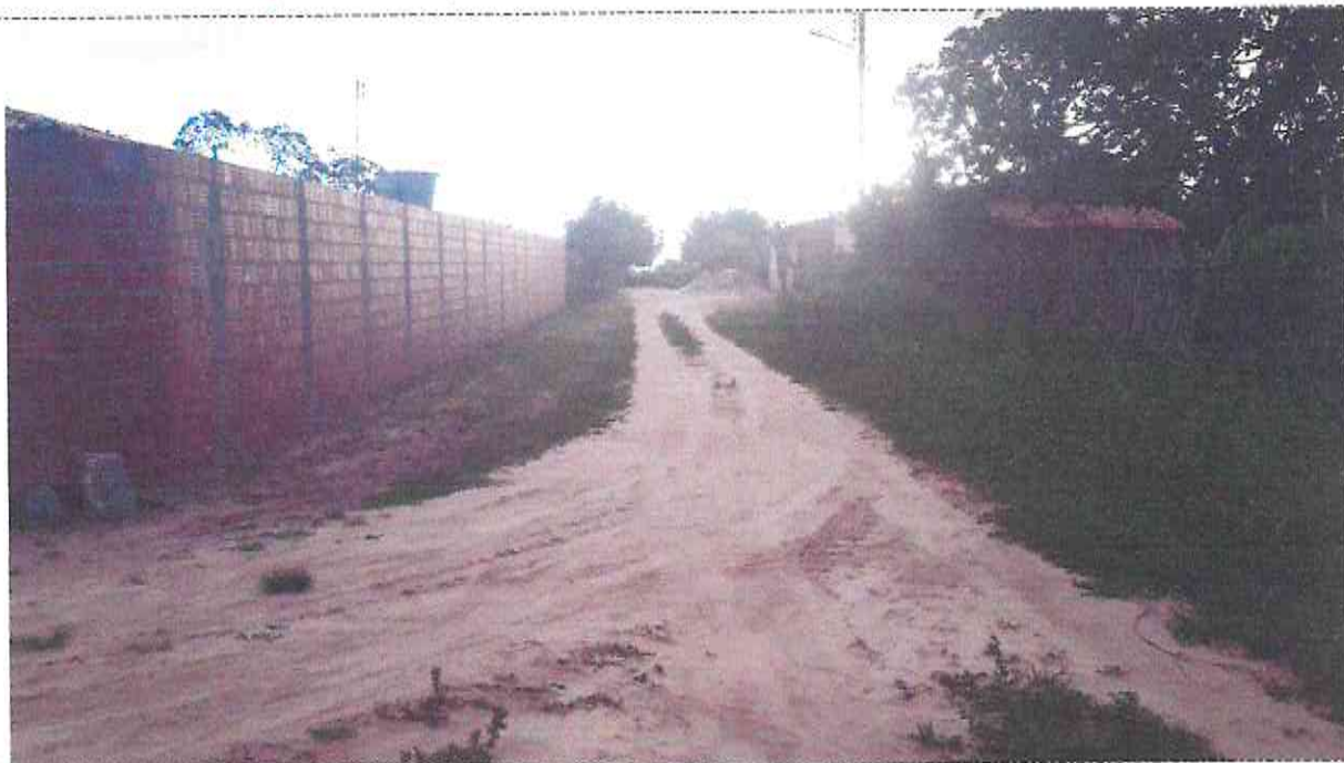
Final (Estaca E18 + 16,00m) do Trecho da Rua Antônio Francisco Machado
