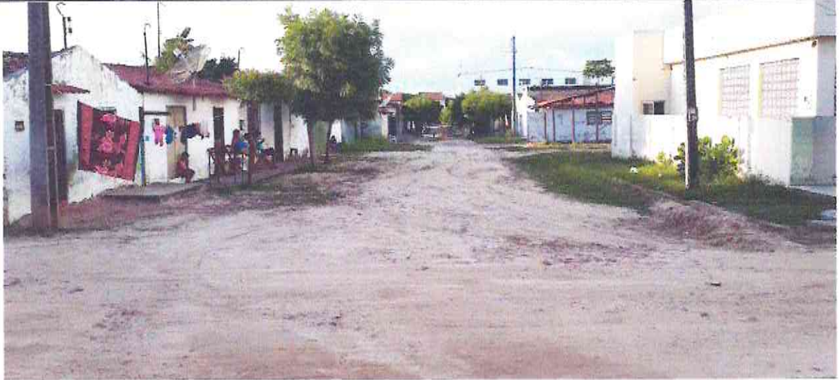
Início (Estaca E00) do Trecho da Rua José Chagas
