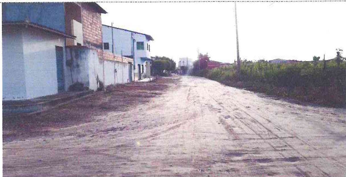
Final (Estaca E12 + 6,20m) do Trecho da Rua Ângelo Da Silva
