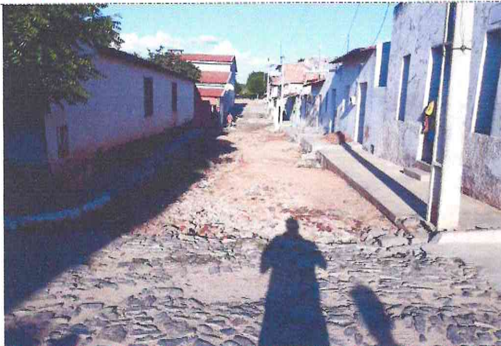
Final (Estaca E02 + 02,53m) da Rua Abílio Vieira - Trecho II (Distrito: Uiraponga)
