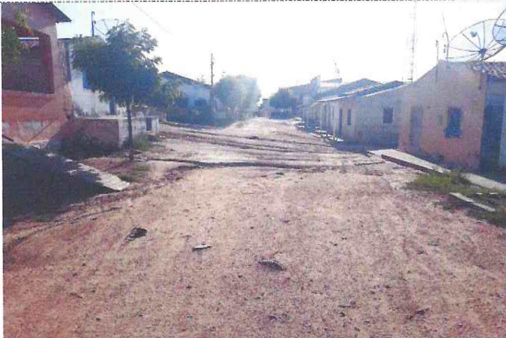
Final (Estaca E05 + 04,89m) da Rua Abílio Vieira - Trecho III (Distrito: Uiraponga)
