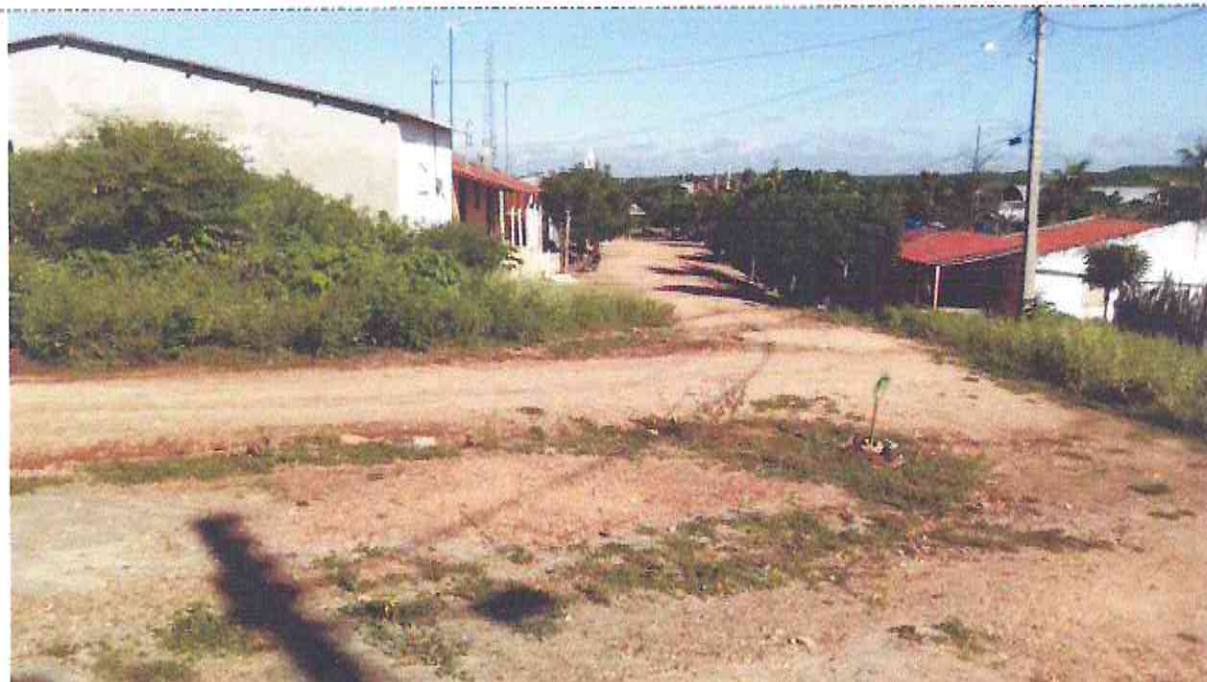
Final (Estaca E13 + 10,90m) da Rua Padre Assis Monteiro (Distrito: Uiraponga)
