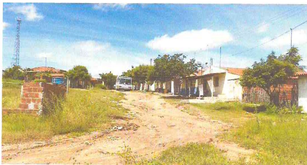
Final (Estaca E07) da Rua Júlio Bernardo
