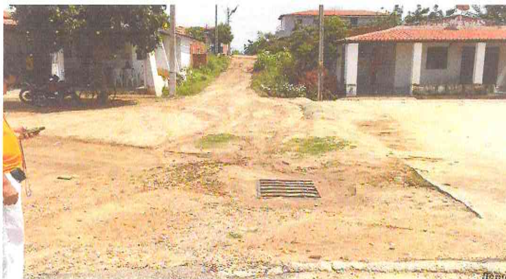
Final (Estaca E04 + 18,50m) da Rua Sem Denominação 02
