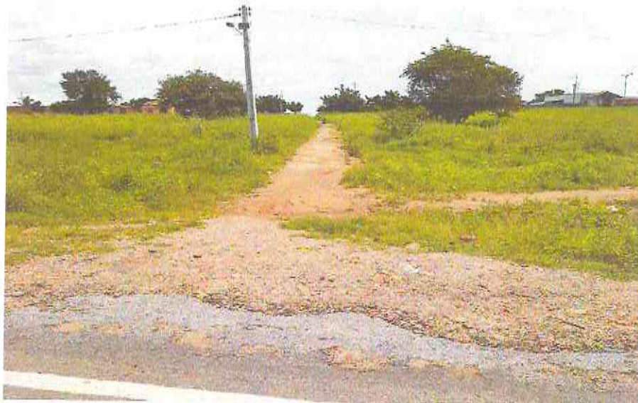
Final (Estaca E14 + 16,40m) da Rua Sem Denominação 01
