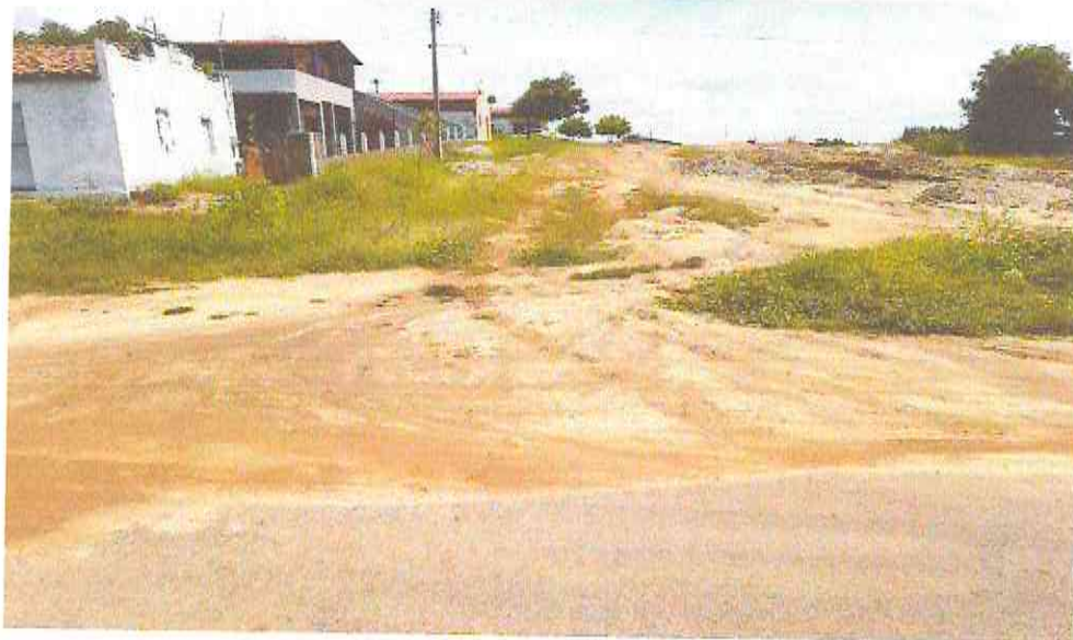
Final (Estaca E04 + 6,00m) da Rua Manoel Bernardo
