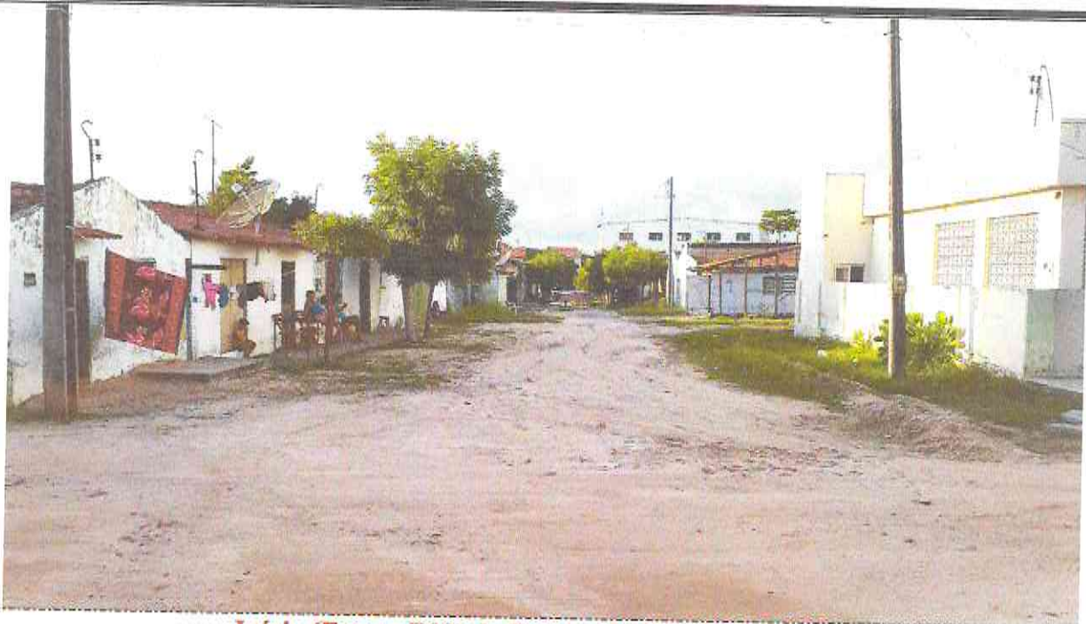
Início (Estaca E00) do Trecho da Rua José Chagas
