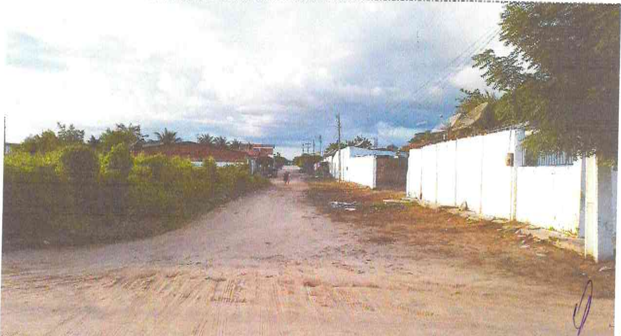
Final (Estaca E14 + 9,45m) do Trecho da Rua Manoel Anastácio
