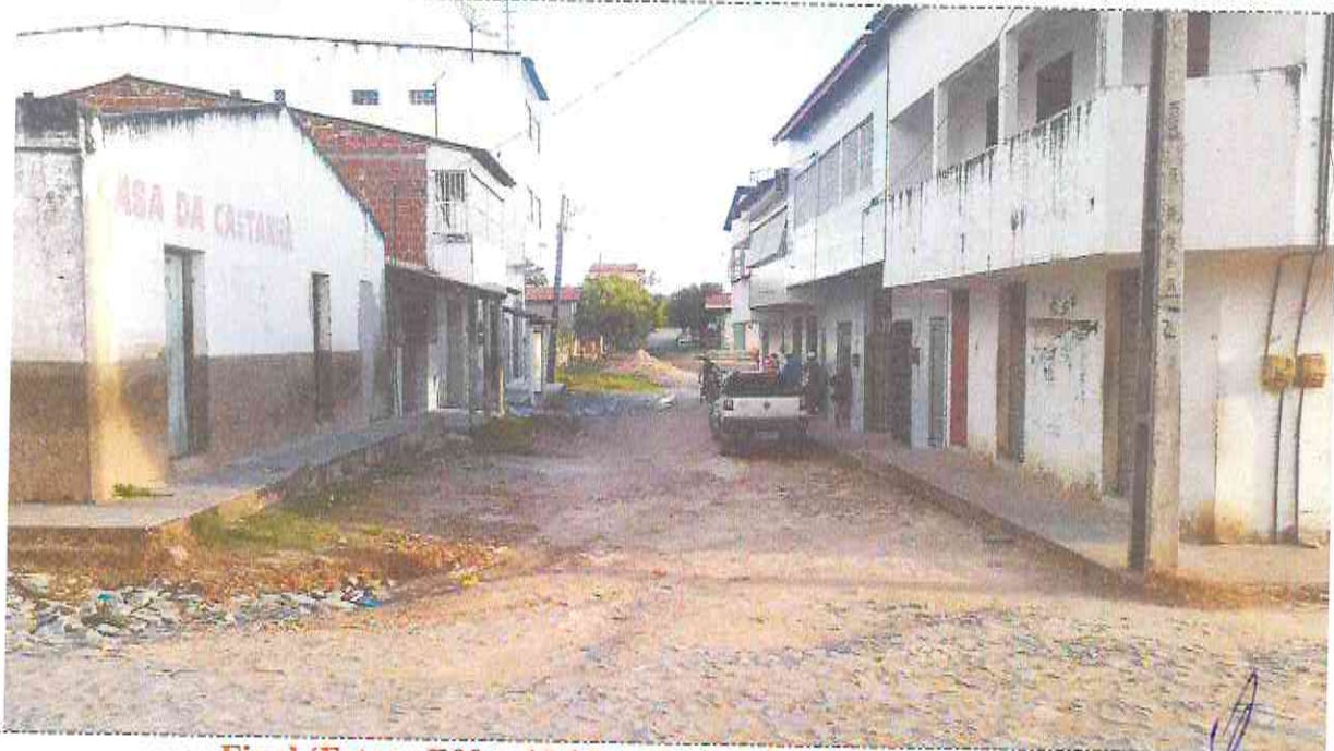
Final (Estaca E09 + 15,85m) do Trecho da Rua José Chagas
