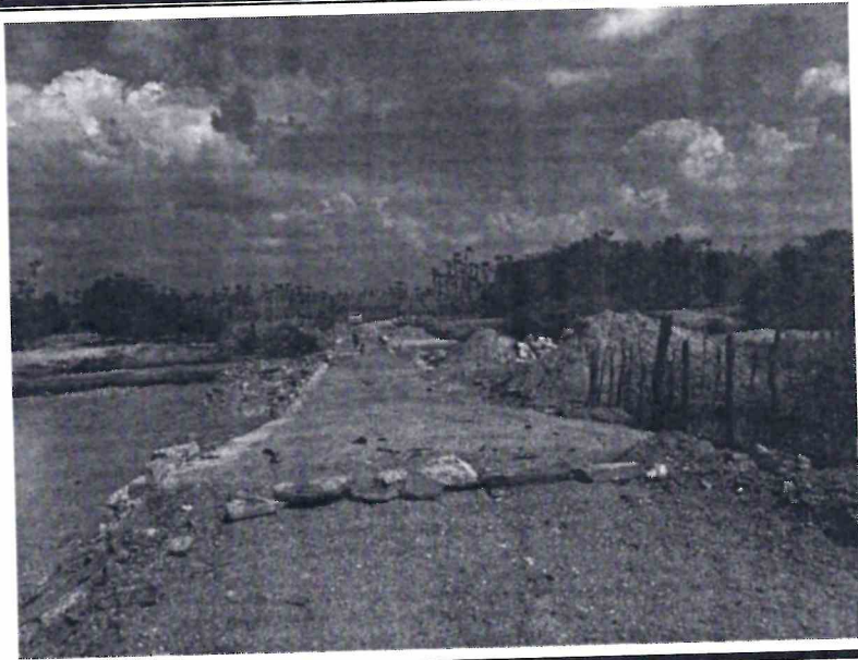
Figura 03 – PASSAGEM MOLHADA LATITUDE: 9423836.41 E / LONGITUDE: 579639.81 S
