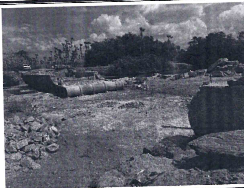
Figura 02 – PASSAGEM MOLHADA LATITUDE: 9423841.47 E / LONGITUDE: 579654.28 S
