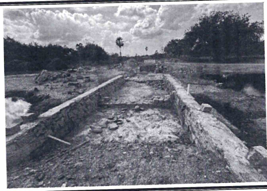
Figura 04 – PASSAGEM MOLHADA LATITUDE: 9423828.36 E / LONGITUDE: 579683.14 S
