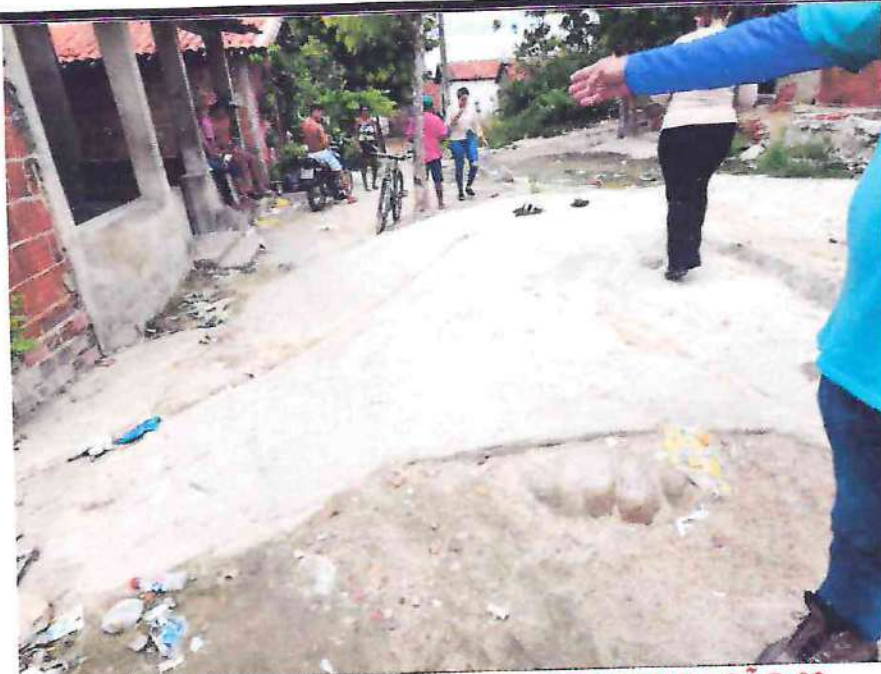
Início (Estaca E00) da RUA SEM DENOMINAÇÃO 02 UTM 568755.87 / 9435371.82
