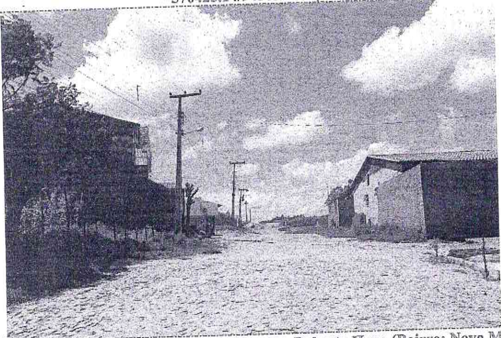
Final (Estaca E02 + 6,75m) do Trecho da Rua Dr. Roberto Hugo (Bairro: Nova Morada) (Coordenada UTM 570382.12/9436399.55)
