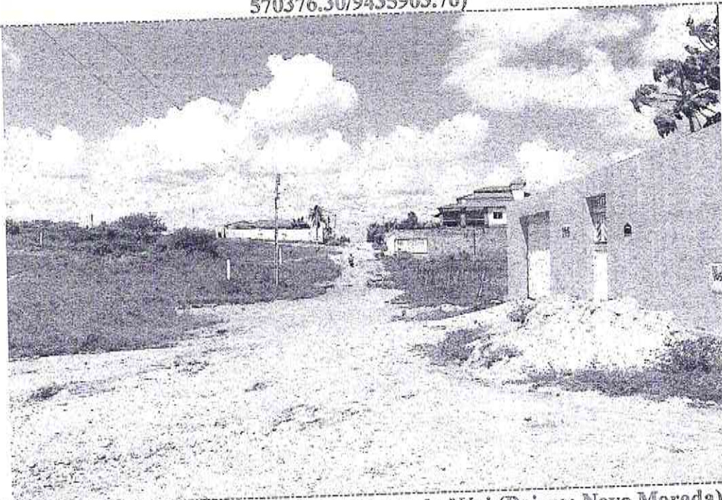
Início (Estaca E00) do Trecho da Rua Raimunda Néri (Bairro: Nova Morada) (Coordenada UTM 570376.30/9435903.76)
