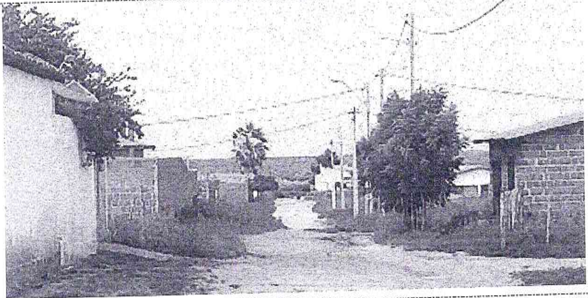
Final (Estaca E06 + 1,55m) Trecho da Rua José Carneiro Filho (Bairro: Vazantes) (Coordenada UTM 573854.65/9436209.01)
