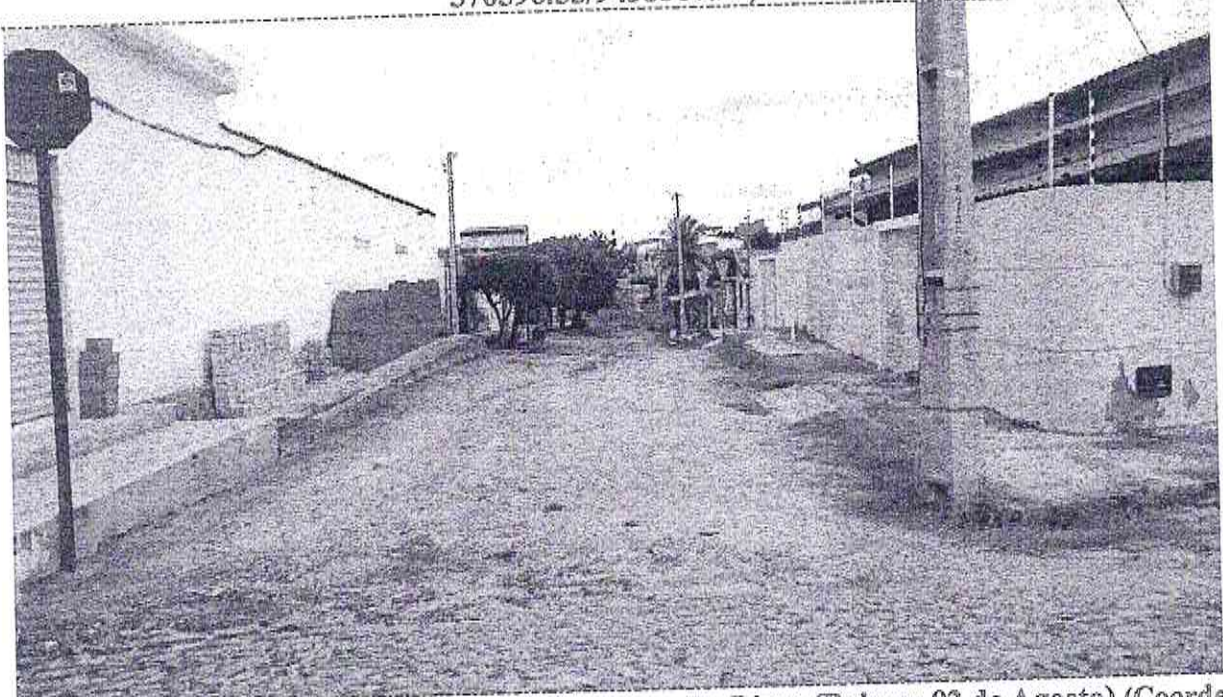
Final (Estaca E16 + 02,56m) da Rua Aluizio Gonzaga De Lima (Bairro: 02 de Agosto) (Coordenada UTM 570635.75/9435706.77)
