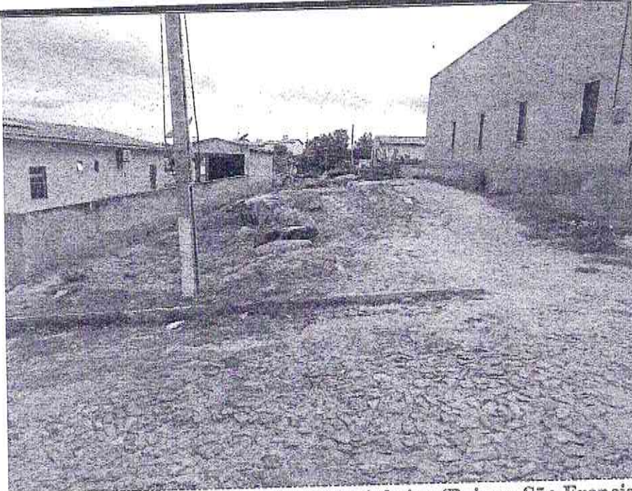
Início (Estaca E00) do Trecho da Rua Henrique Marinheiro (Bairro: São Francisco) (Coordenada UTM 570150.28/9435965.24)
