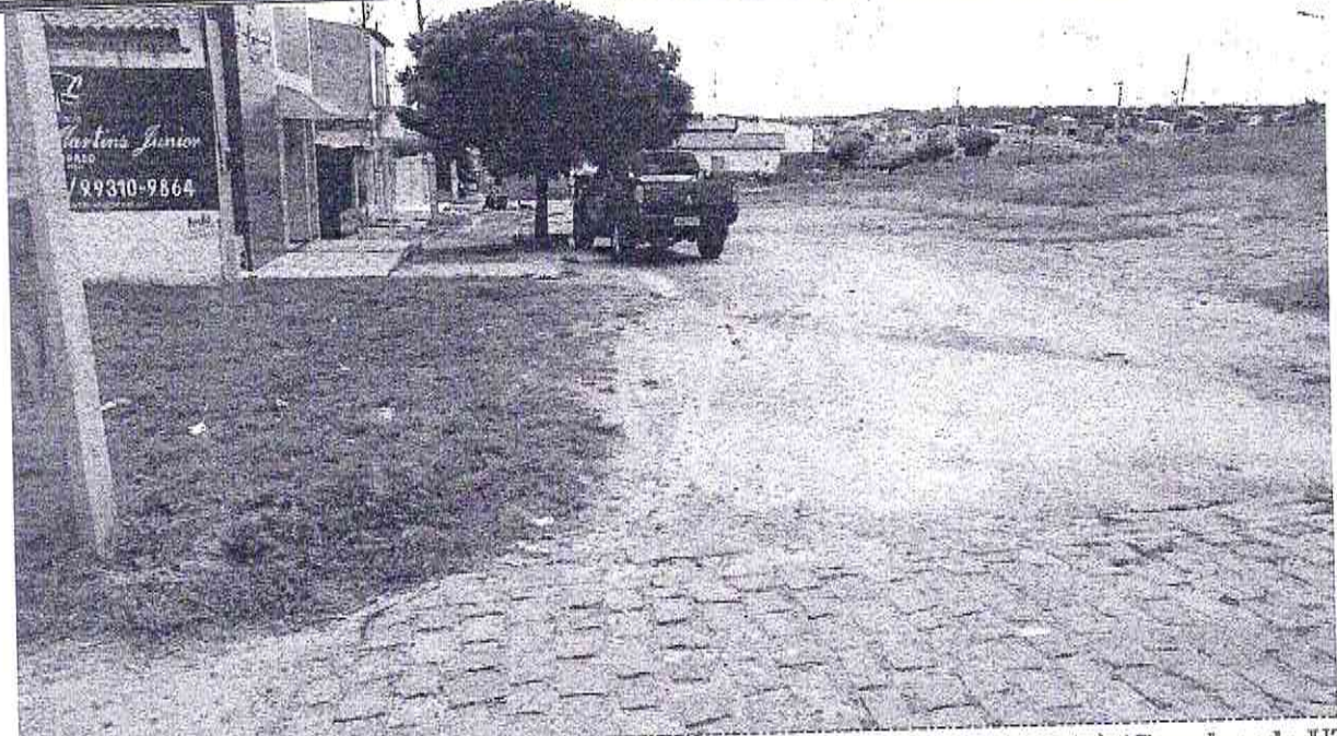
Início (Estaca E00) da Rua Aluizio Gonzaga De Lima (Bairro: 02 de Agosto) (Coordenada UTM 570596.55/9435387.95)
