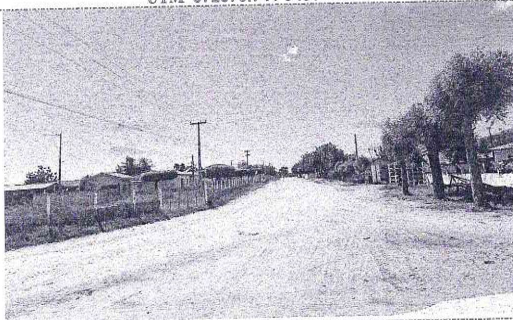
Final (Estaca E17 + 2,44m) RUA SEM DENOMINAÇÃO 04 (SETOR 1) UTM 573211.23 / 9433479.12
